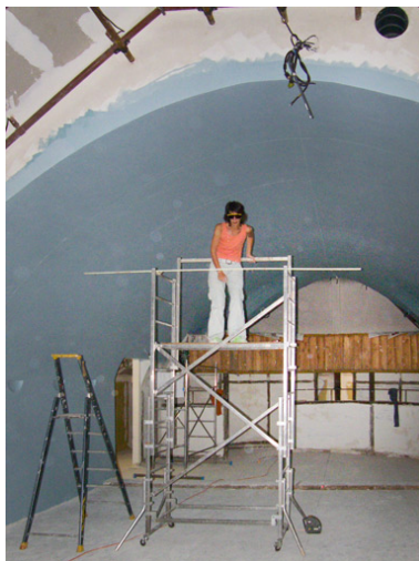
[Réfection des peintures de la voûte : la restauratrice sur l'échafaudage]. 2008. Phot. Danièle Mouton IVR26_20238900269NUC4A
