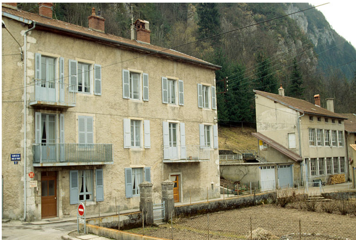
Vue d'ensemble des bâtiments chemin de la Combe du Marais, depuis le nord.
