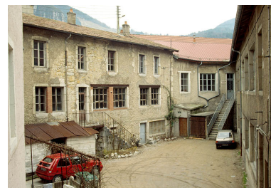
Bâtiments rue Carnot : vue d'ensemble. Phot. Laurent Poupard IVR43_19923901456ZA
