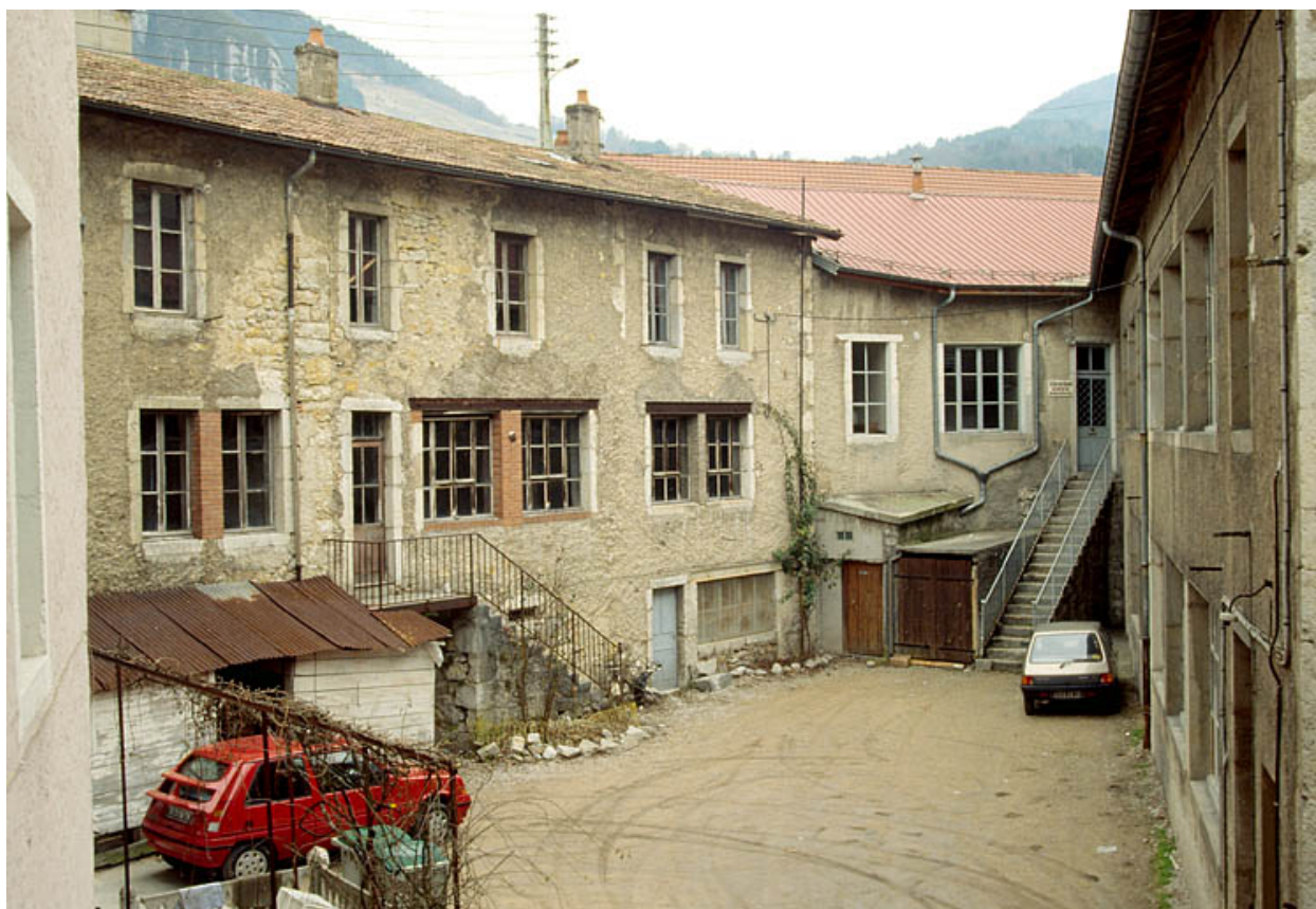
Bâtiments rue Carnot : vue d'ensemble.
