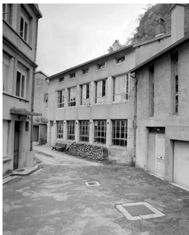
Atelier de fabrication chemin de la Combe du Marais, de trois quarts droite. Phot. Jérôme Mongreville IVR43_19923900532X
