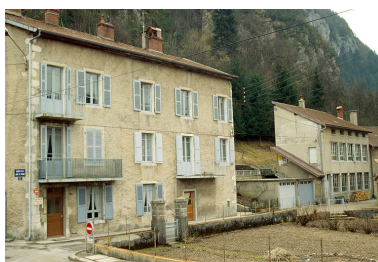
Vue d'ensemble des bâtiments chemin de la Combe du Marais, depuis le nord. Phot. Laurent Poupard IVR43_19923901458ZA
