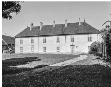
Vue du logis. Phot. Yves Sancey IVR43_19843900041X
