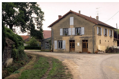
Vue d'ensemble. Phot. Jérôme Mongreville IVR43_19953900444ZA
