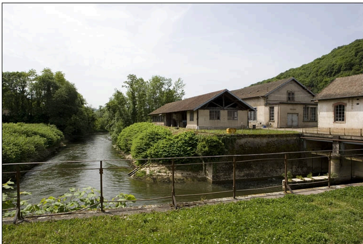
Bief de dérivation et hangar industriel.
