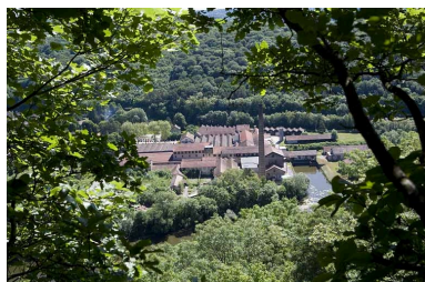
Vue plongeante depuis l'ouest. Phot. Yves Sancey IVR43_20092500588NUC2A
