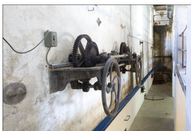
Bâtiment d'eau. Phot. Yves Sancey IVR43_20092500666NUC2A
