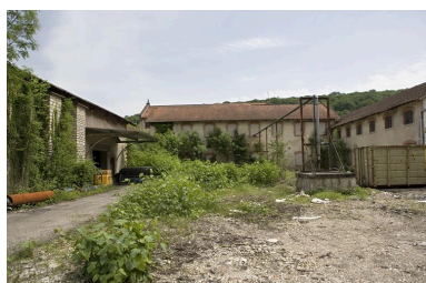
Entrepôt industriel (?). Façade ouest.
