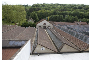
Magasin industriel. Vue de face d'un shed.
