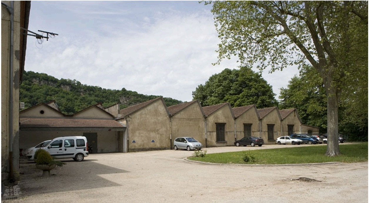
Entrepôt industriel. Pignons des sheds.
