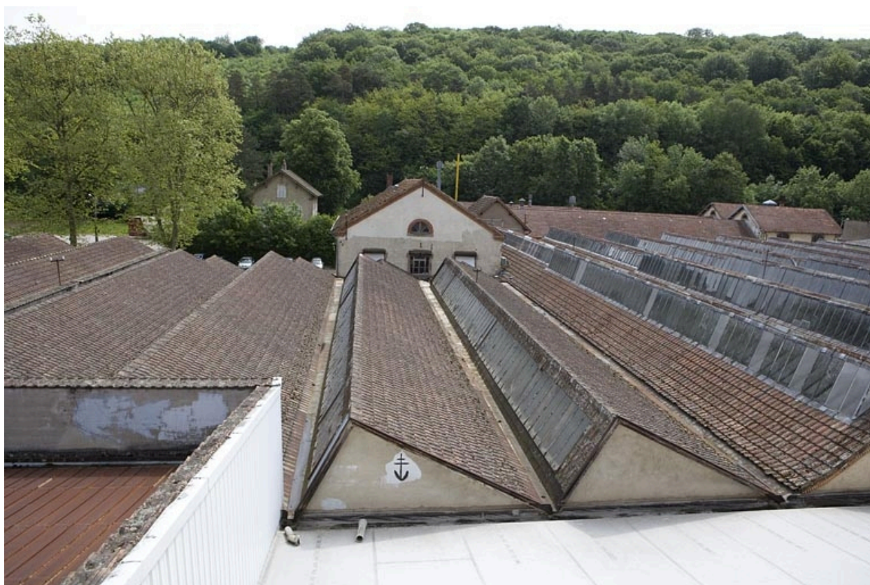
Magasin industriel. Vue de face d'un shed.
