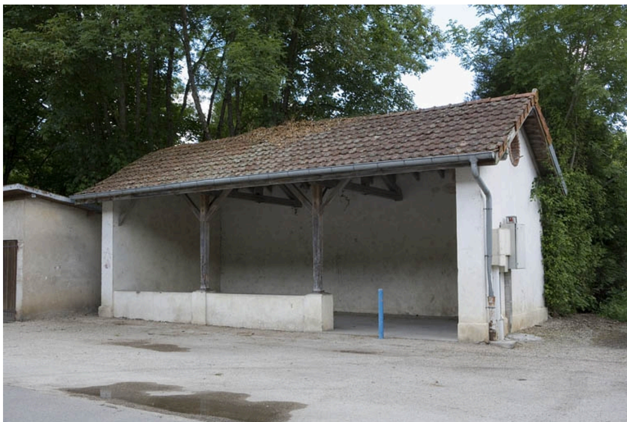
Cité ouvrière. Lavoir.
