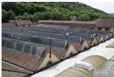
Atelier de fabrication. Vue des toitures.
