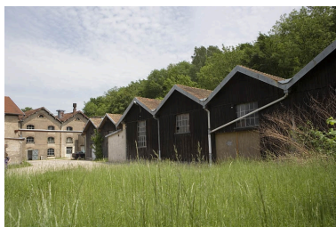
Magasin industriel (désaffecté). Vue de trois quarts.
