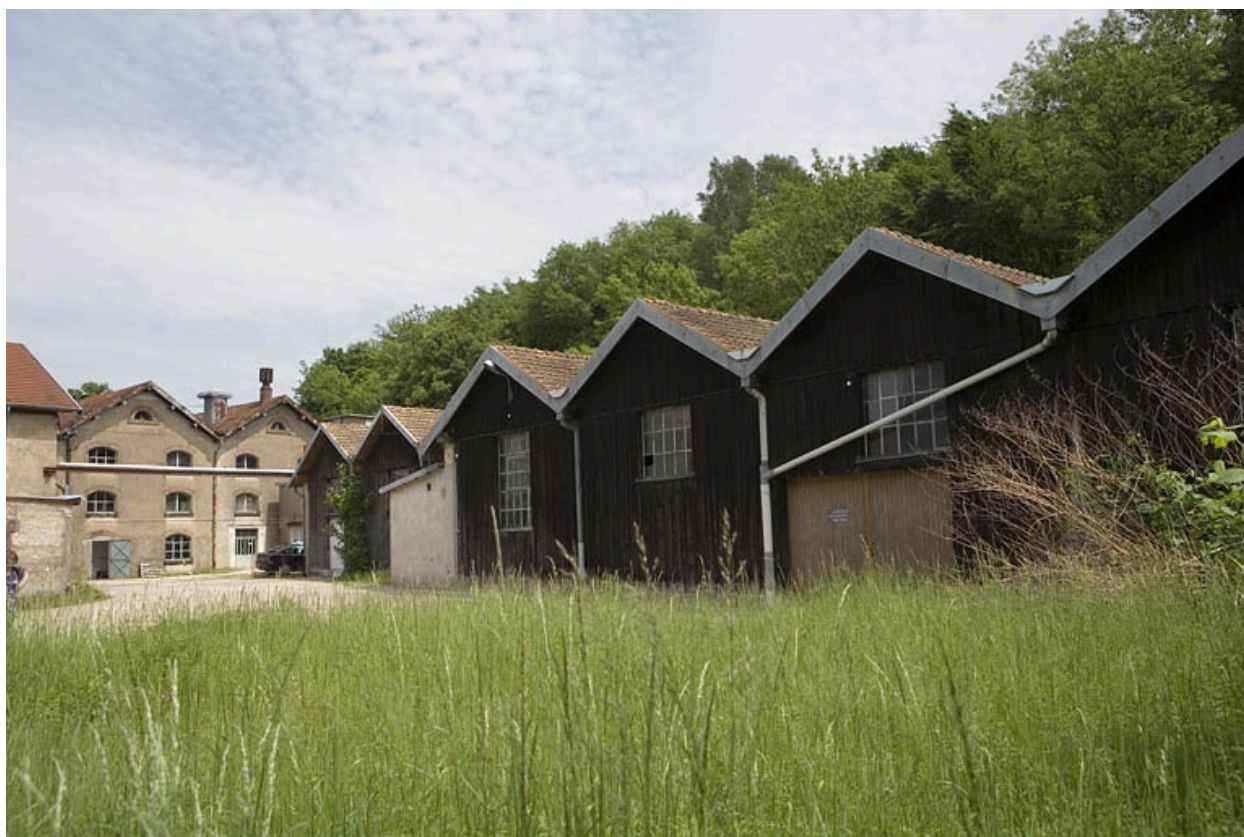
Magasin industriel (désaffecté). Vue de trois quarts.
