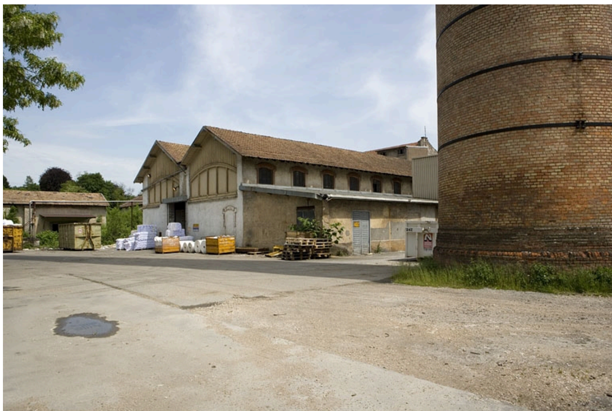
Entrepôt industriel. Pignon ouest.
