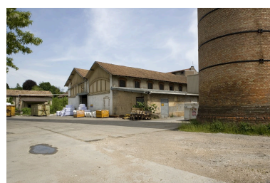
Entrepôt industriel. Pignon ouest.
