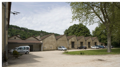
Entrepôt industriel. Pignons des sheds. Phot. Yves Sancey
