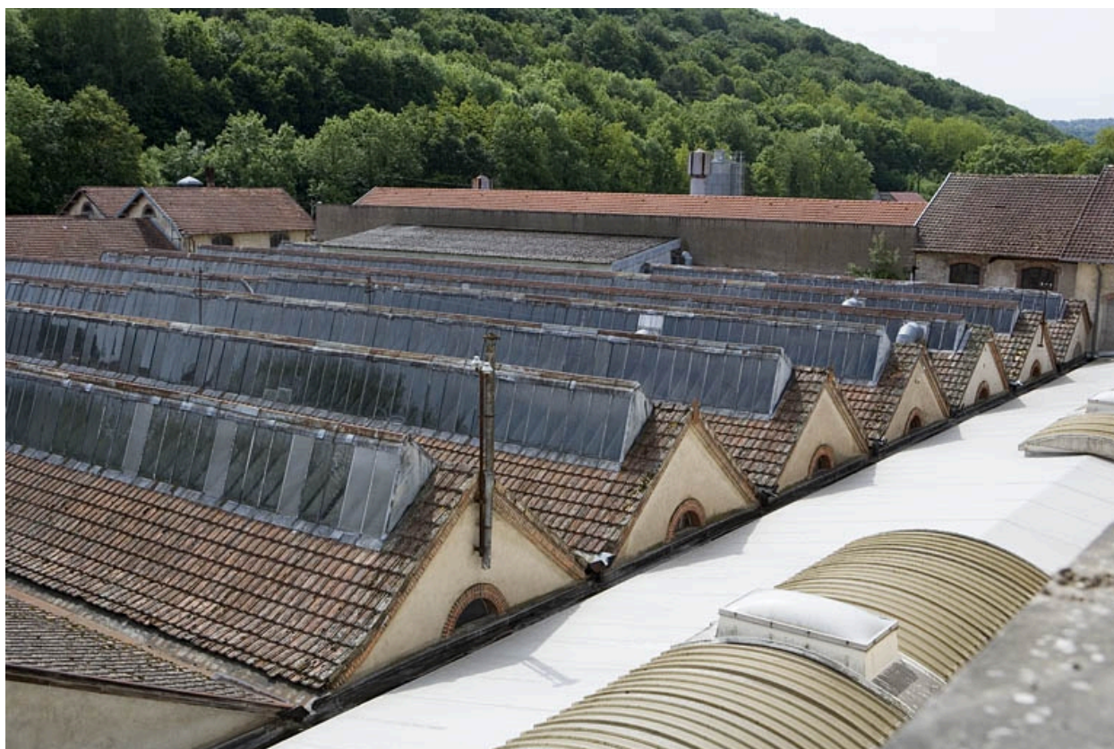
Atelier de fabrication. Vue des toitures.
