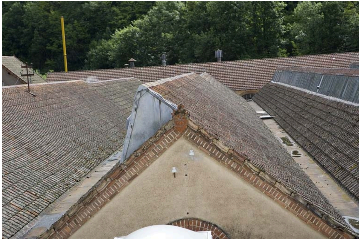
Atelier de fabrication. Acrotère.
