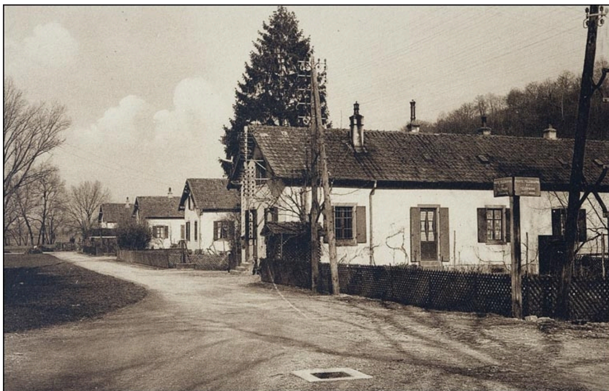
Cité ouvrière, rue de la Poste.
