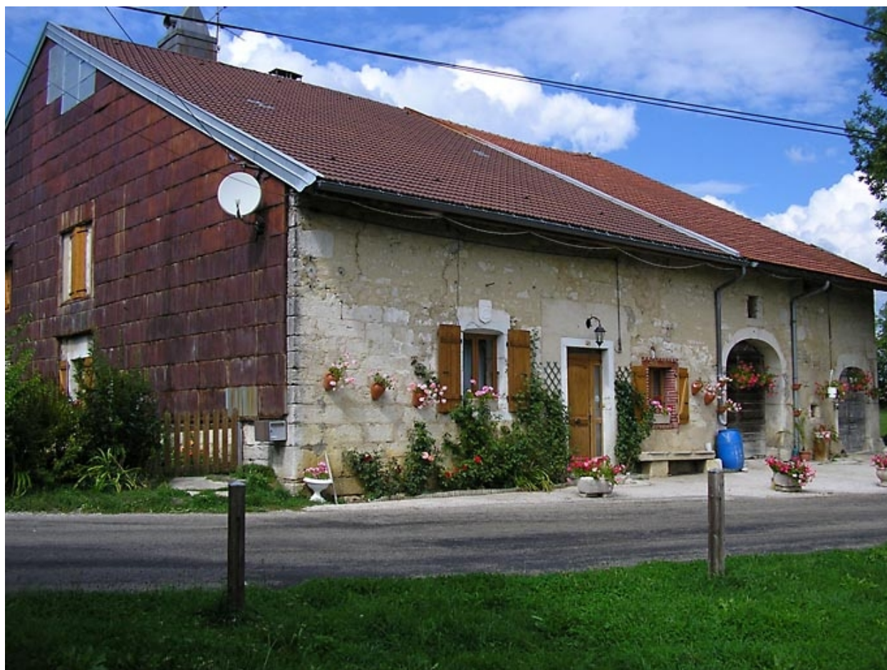
Ferme située 29 route de Saint-Pierre.
