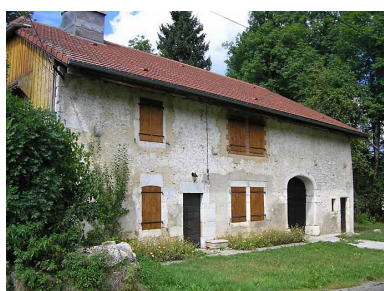
Ferme située 38 route de Saint-Pierre. Phot. Marie-Pierre Reynet IVR43_20083900074NUC1A
