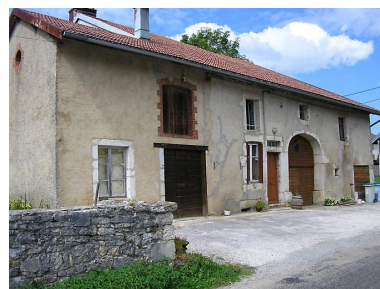
Ferme située 31 route de Saint-Pierre. Phot. Marie-Pierre Reynet IVR43_20083900076NUC1A
