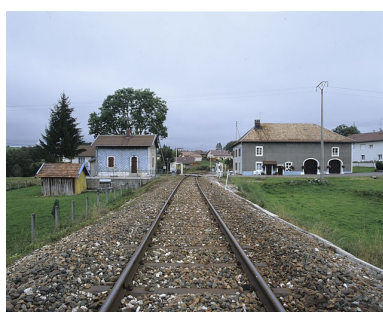
maison de garde-barrière et passage à niveau n° 25 (voie ferrée Andelot - La Cluse). Phot. Yves Sancey IVR43_20043900233XA
