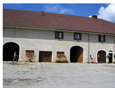
Ferme située 51 route de Saint-Pierre. Phot. Marie-Pierre Reynet IVR43_20083900070NUC1A
