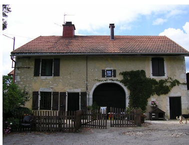
Ferme située 11 route de Saint-Pierre. Phot. Marie-Pierre Reynet IVR43_20083900083NUC1A
