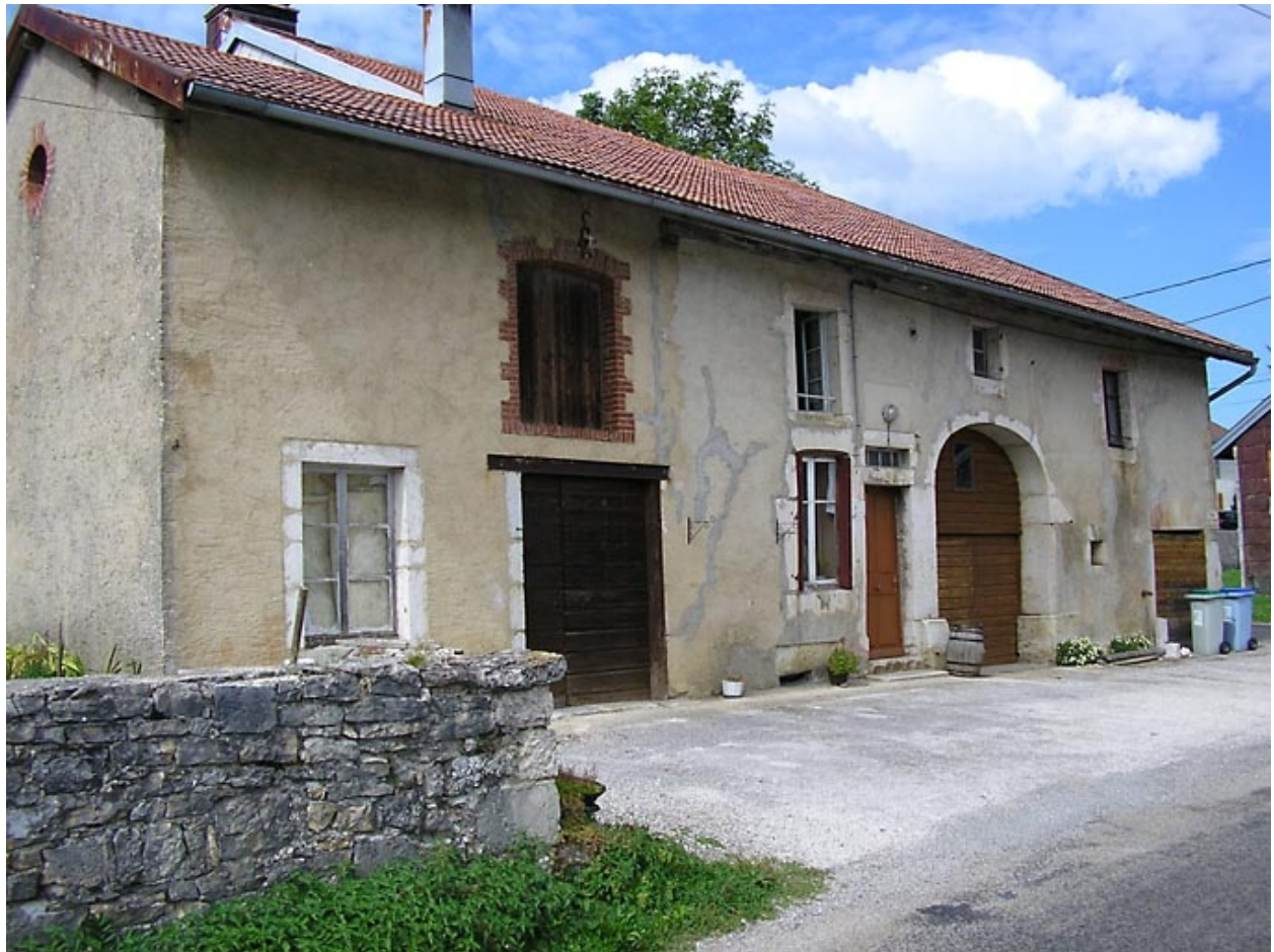
Ferme située 31 route de Saint-Pierre.
