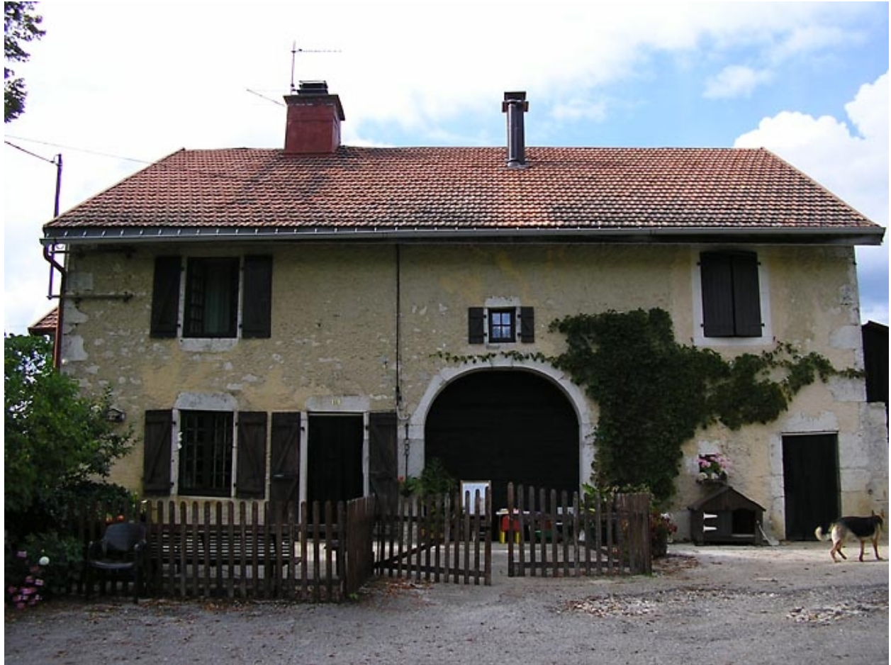
Ferme située 11 route de Saint-Pierre.
