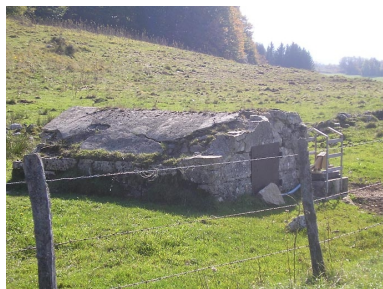
Citerne située au lieu-dit Les Chauvettes de Vent. Phot. Marie-Pierre Reynet IVR43_20083900098NUC1A
