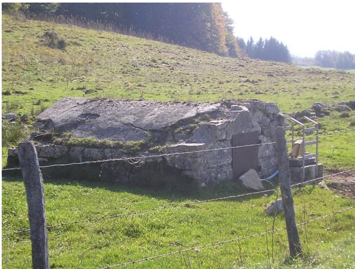
Citerne située au lieu-dit Les Chauvettes de Vent.
