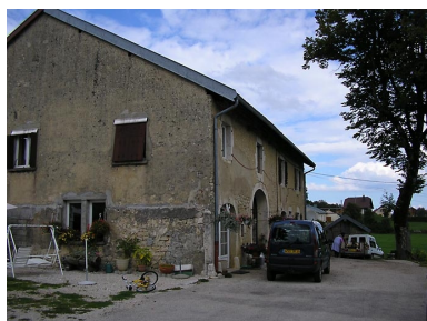
Ferme située 123 route de Saint-Pierre. Phot. Marie-Pierre Reynet IVR43_20083900079NUC1A
