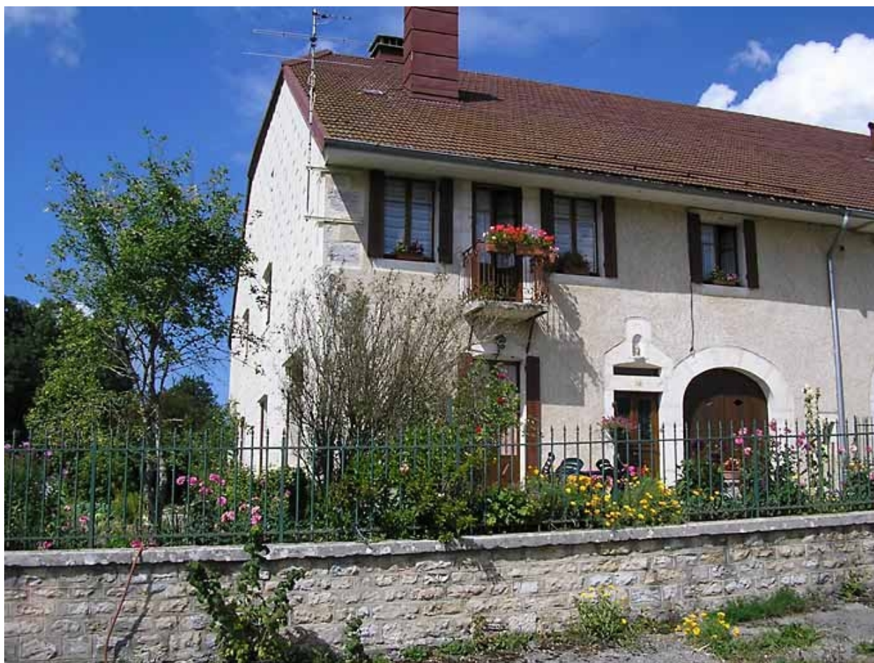
Ferme située 52 route de Saint-Pierre.
