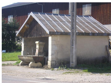
Fontaine-lavoir-abreuvoir située au lieu-dit Pont de Lemme. Phot. Marie-Pierre Reynet
