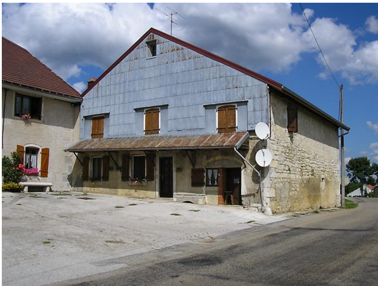
Ferme située 50 route de Saint-Pierre.
