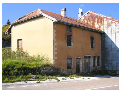
Maison située au lieu-dit Pont de Lemme. Phot. Marie-Pierre Reynet IVR43_20083900105NUC1A
