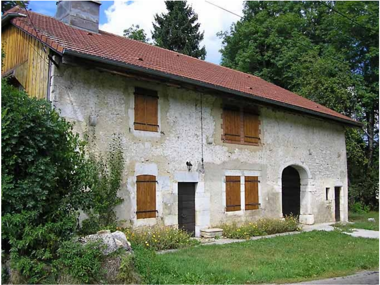
Ferme située 38 route de Saint-Pierre.
