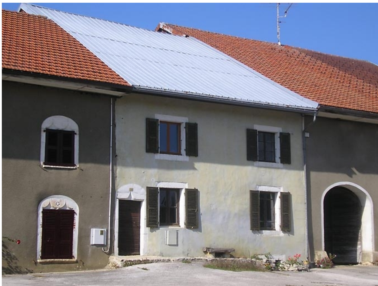
Ferme située au lieu-dit Les Chauvettes du Vent.
