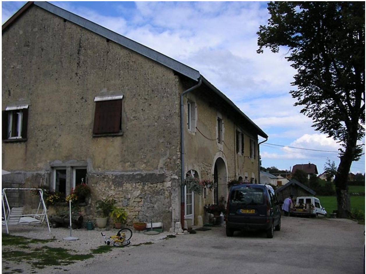
Ferme située 123route de Saint-Pierre.
