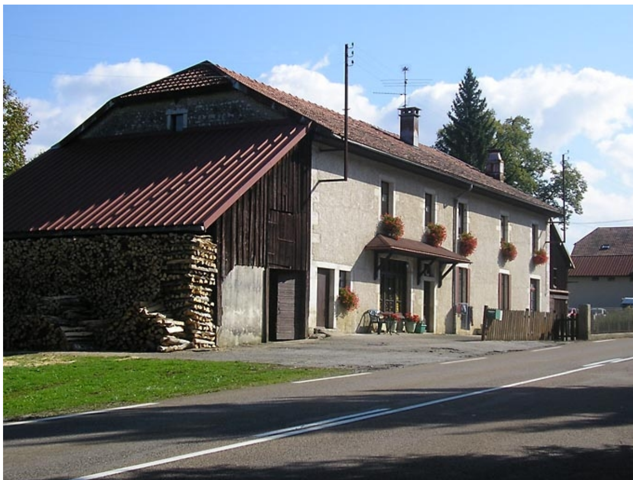
Caserne de douaniers, actuellement maison située au lieu-dit Pont de Lemme.
