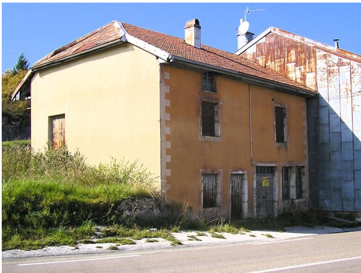
Maison située au lieu-dit Pont de Lemme.
