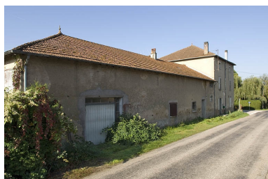
Atelier et logement depuis l'est. Phot. Jérôme Mongreville IVR43_20067000820NUCA
