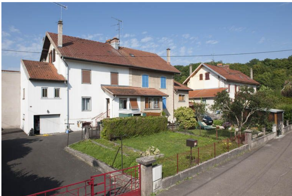
Habitations à 4 logements vues de trois quarts.
