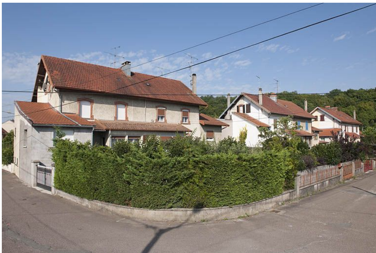
Habitations à 4 logements vues depuis l'est.
