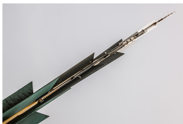
Détail de la flèche. Phot. Jérôme Mongreville IVR43_20143900216NUC4A
