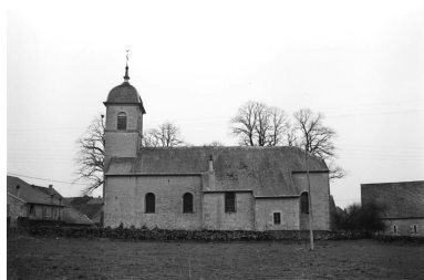
Façade latérale droite. Phot. Guy Forestier IVR43_19743900972Z
