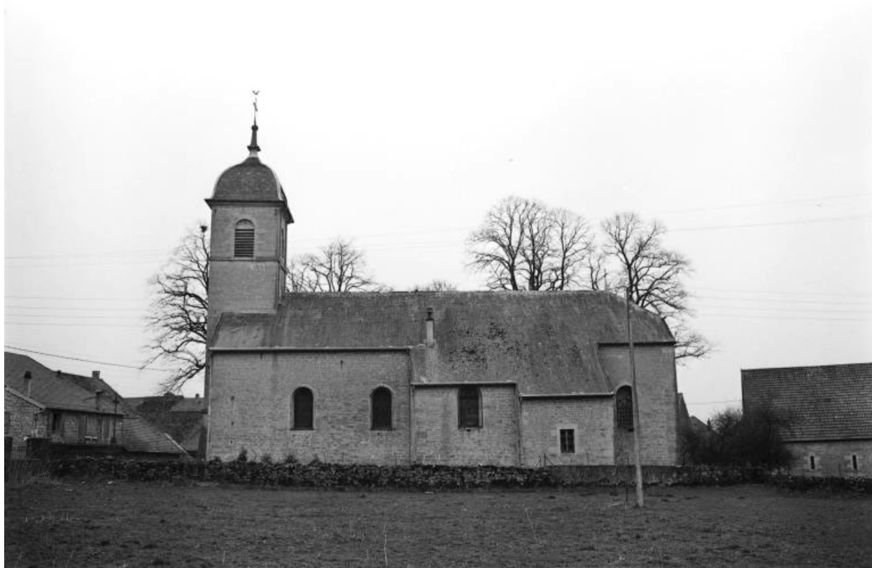
Façade latérale droite.
