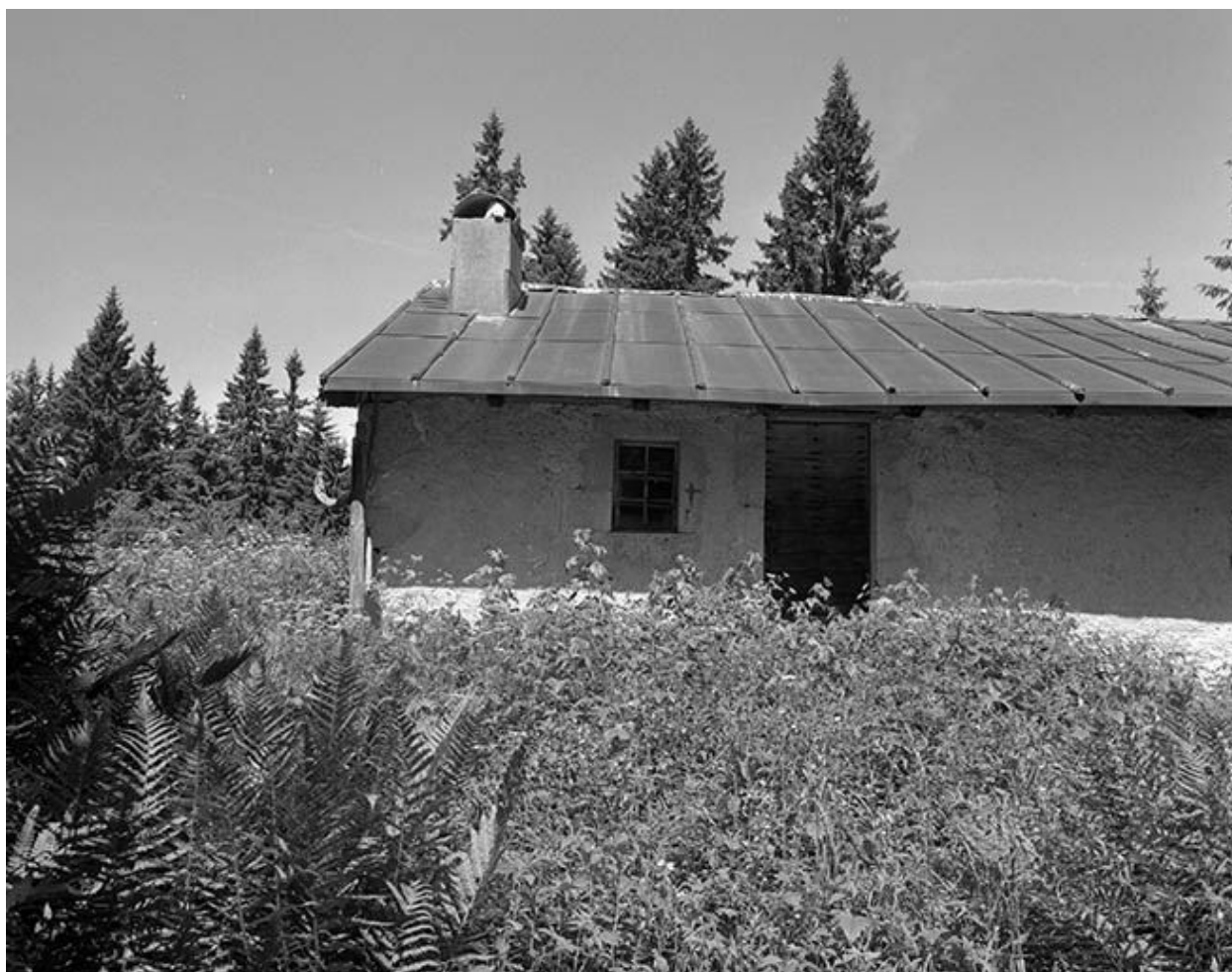
Porte d'accès de la façade antérieure.
