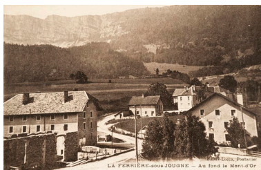
La Ferrière-sous-Jougne - Au fond le Mont-d'Or [au premier plan à gauche la salle des fêtes en construction], entre 1914 et 1921.
