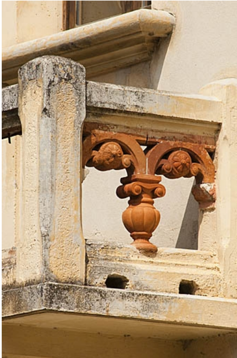
Motif en céramique ornant le garde-corps du balcon.
