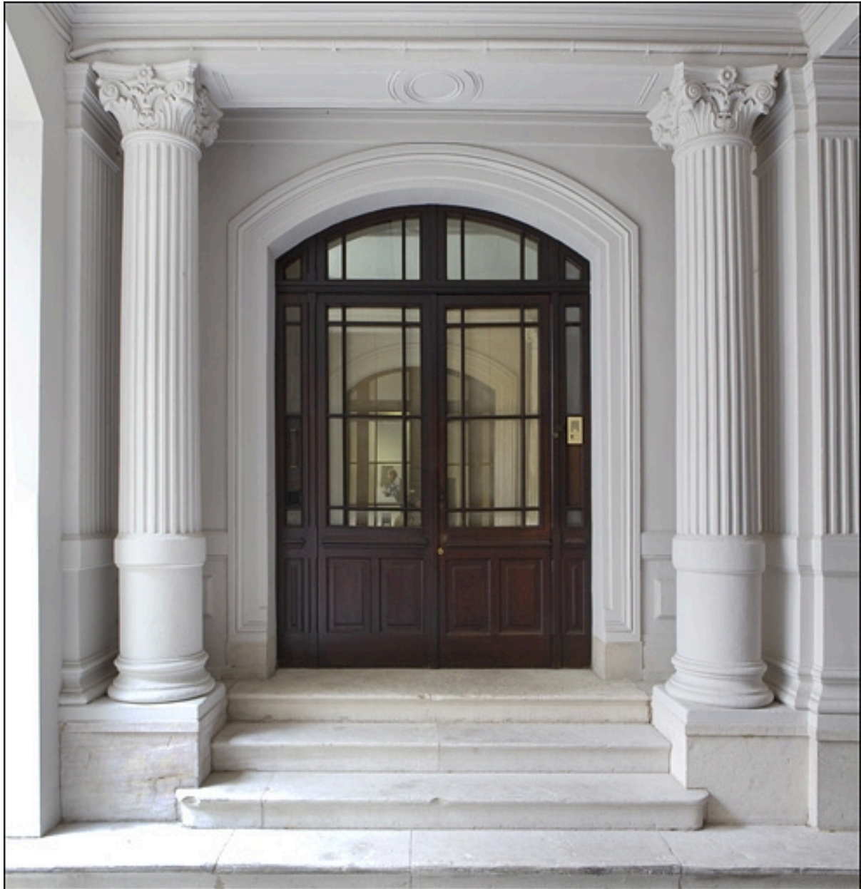
Détail de la porte d'entrée, à droite du passage cocher, permettant d'accéder à l'appartement du premier étage.
