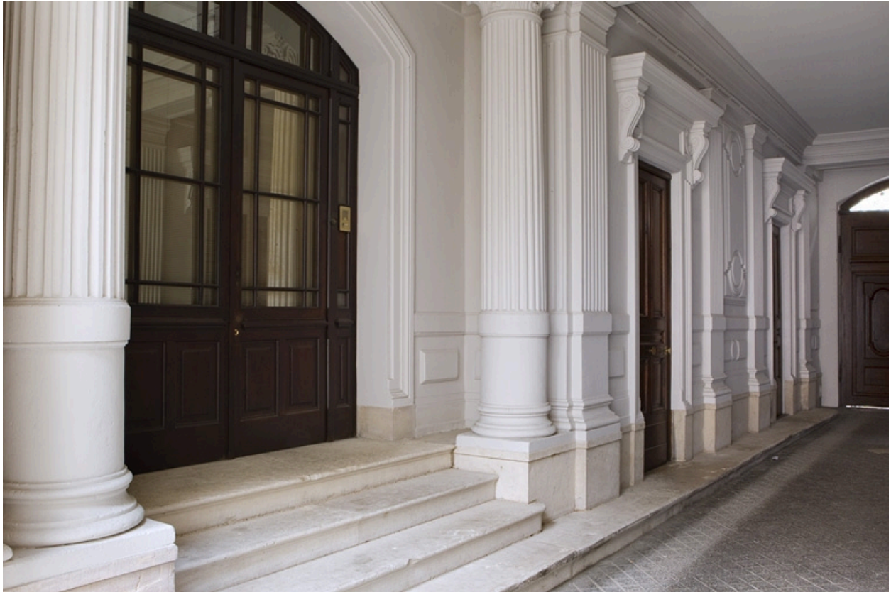
Passage cocher :détail du mur droit.
