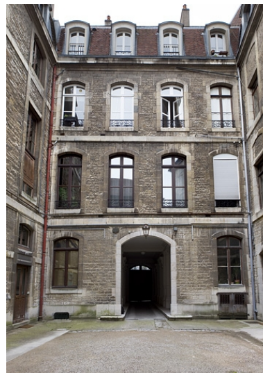
Façade postérieure sur cour : vue d'ensemble de face. Phot. Yves Sancey IVR43_20102500866NUC2A
