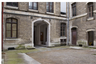
Façade postérieure sur cour : détail du rez-de-chaussée de trois quarts gauche. Phot. Yves Sancey IVR43_20102500850NUC2A
