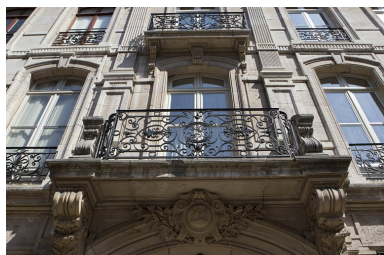
Détail de de deux balcons au dessus du portail d'entrée. Phot. Yves Sancey IVR43_20102500842NUC2A
