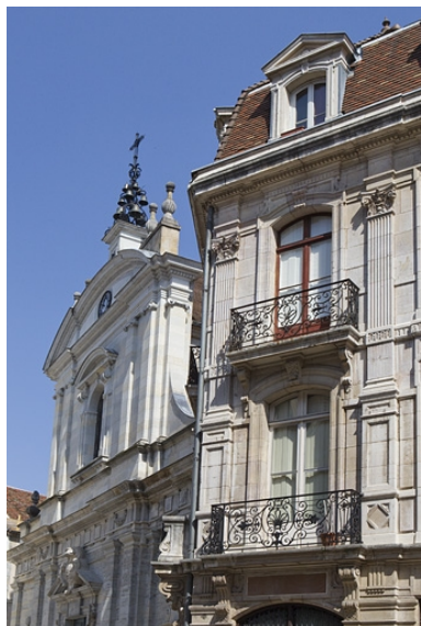
Détail de de deux balcons à gauche de la façade antérieure. Phot. Yves Sancey IVR43_20102500841NUC2A
