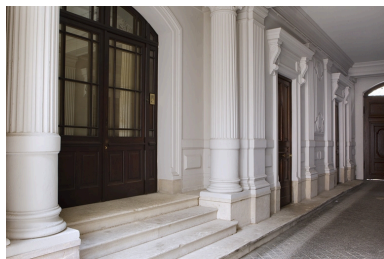
Passage cocher : détail du mur droit. Phot. Yves Sancey IVR43_20102500852NUC2A
