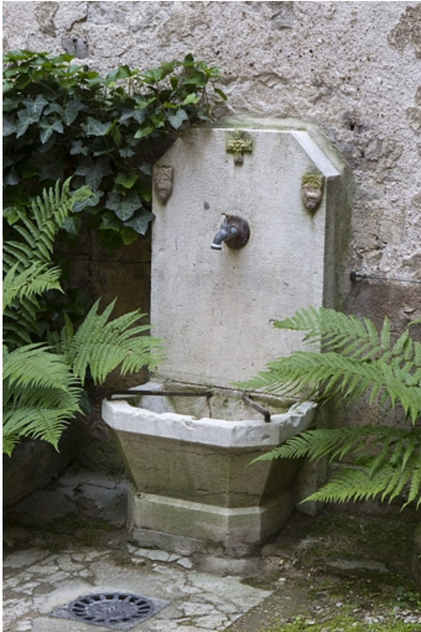
Cour : vue d'ensemble de la borne fontaine.
