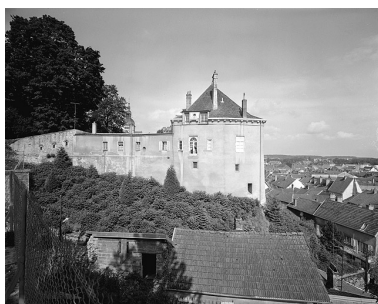
Vue d'ensemble depuis la rue du Tertre du Palais. Phot. Yves Sancey IVR43_19917000314V
