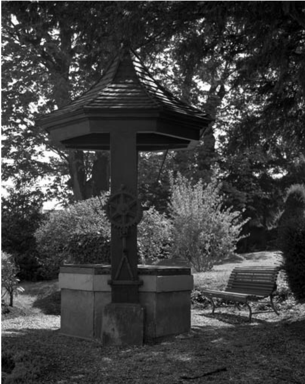
Vue d'ensemble du puits.
