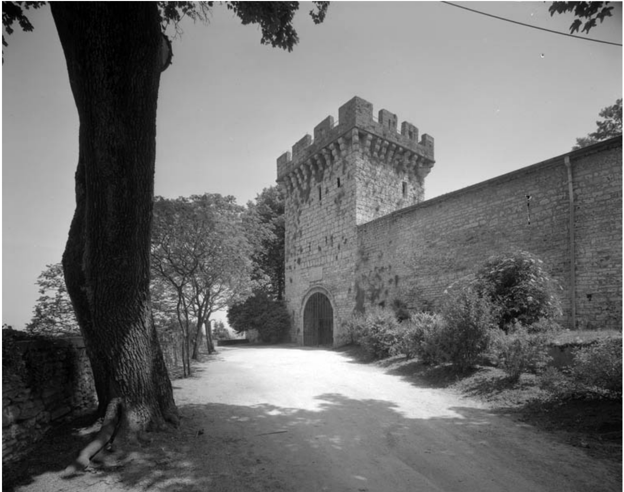
Ouvrage d'entrée, dit tour du Paravis : vue éloignée.
