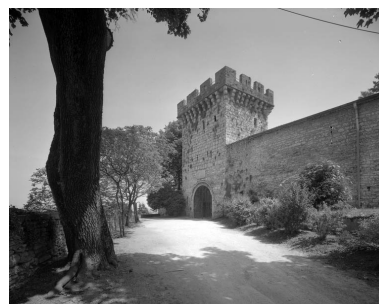
Ouvrage d'entrée, dit tour du Paravis : vue éloignée. Phot. Yves Sancey IVR43_19917000315V
