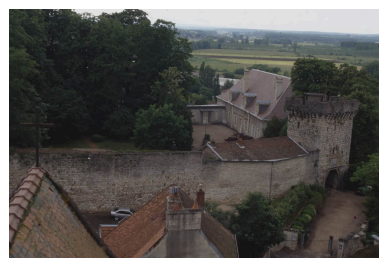
Vue d'ensemble. Phot. Yves Sancey IVR43_19987000057ZA
