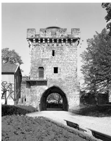
Ouvrage d'entrée, dit tour du Paravis : de face, depuis le parc du musée. Phot. Yves Sancey IVR43_19917000317X
