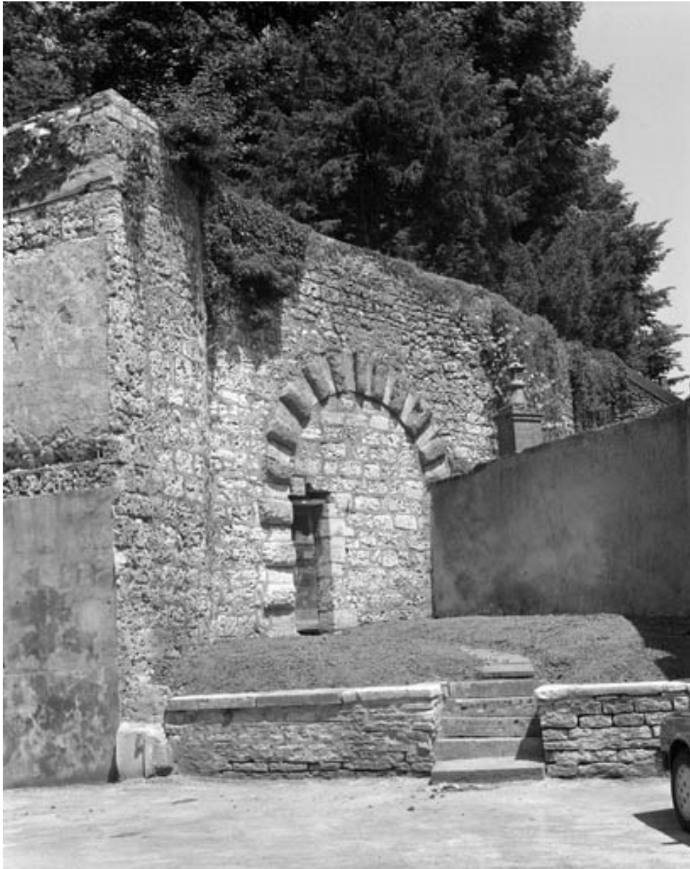
Vue du mur d'enceinte à gauche du bâtiment du musée.
