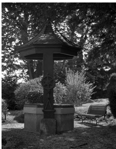
Vue d'ensemble du puits. Phot. Yves Sancey IVR43_19917000327X
