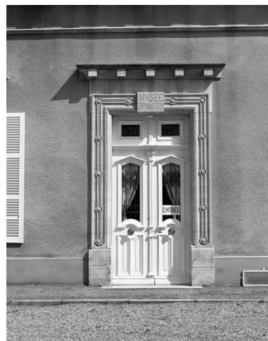
Porte d'entrée du musée, de face. Phot. Yves Sancey IVR43_19917000326X
