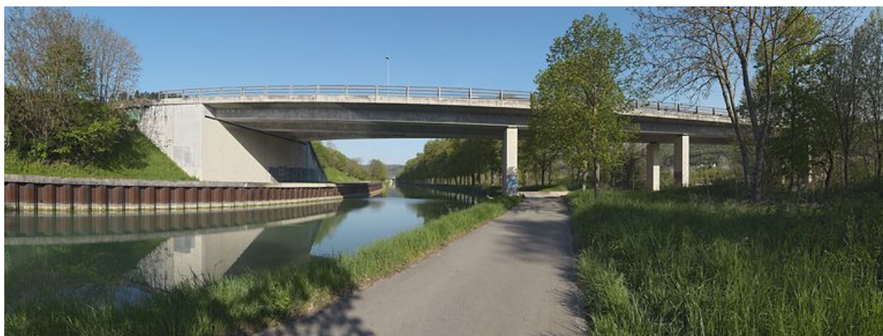
Pont vu d'aval.
