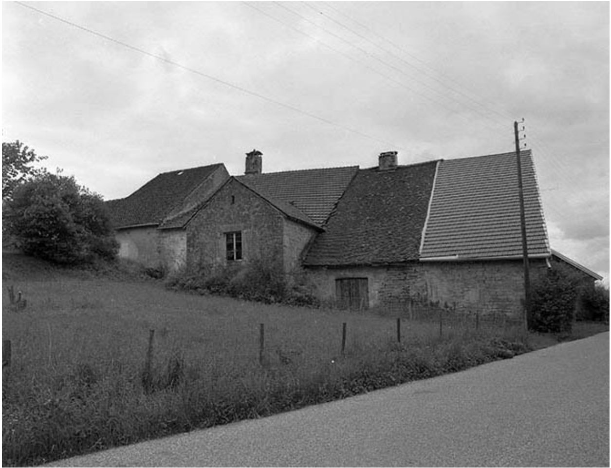
Façade postérieure avec les deux fermes voisines
