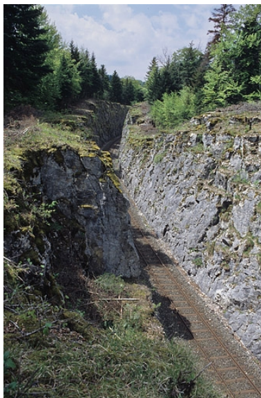
Tranchée côté Andelot-en-Montagne, vue du pont.
