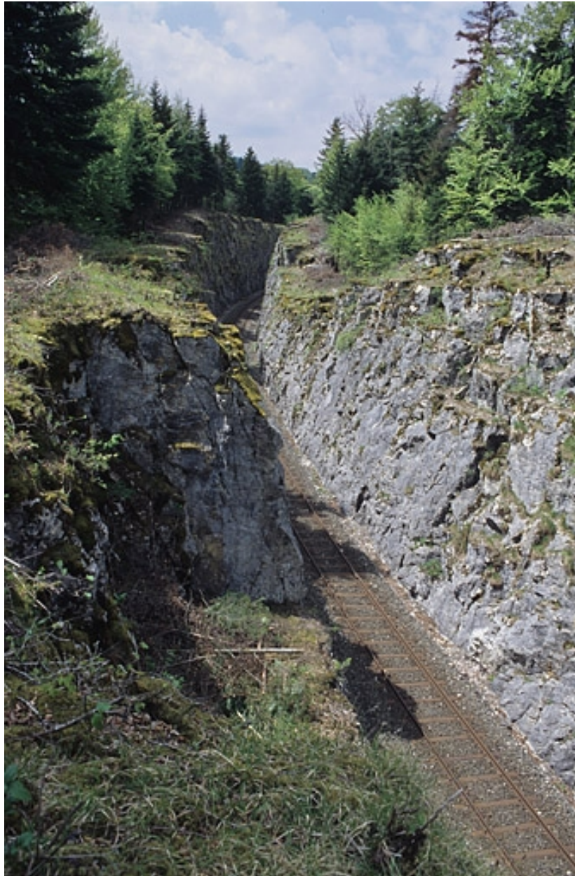
Tranchée côté Andelot-en-Montagne, vue du pont.
