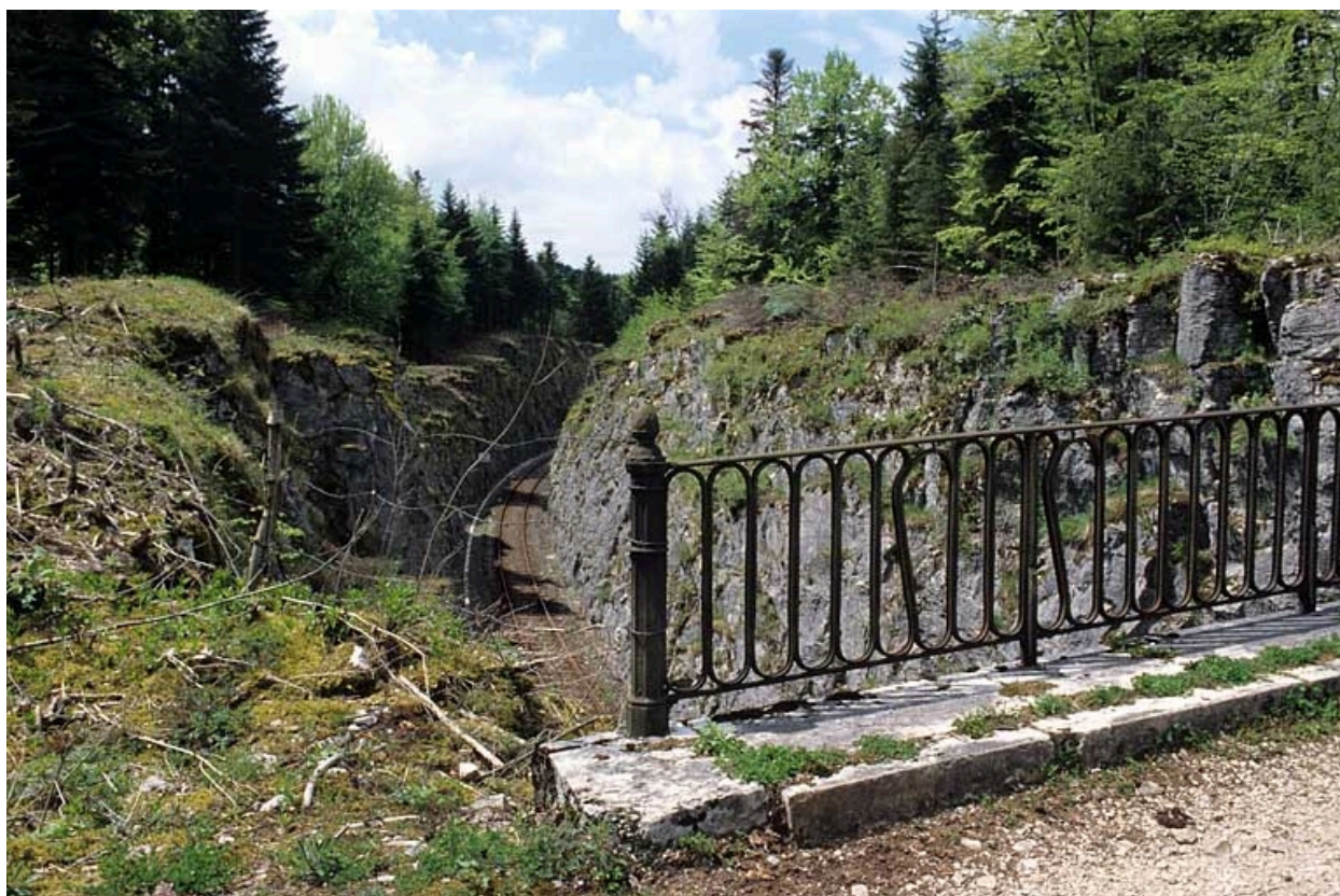
Tranchée côté Andelot-en-Montagne et détail du garde-corps.
