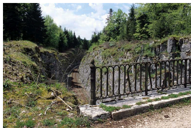
Tranchée côté Andelot-en-Montagne et détail du garde-corps.
