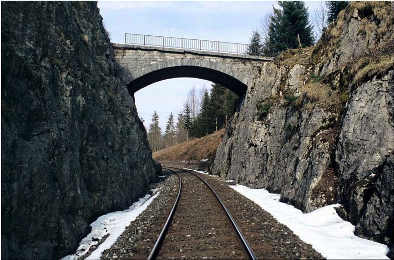
Vue d'ensemble, depuis la voie (côté Andelot-en-Montagne).
