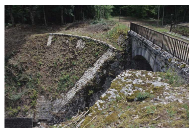
Mur en quart de cône pointe en bas. Phot. Yves Sancey IVR43_20053900126ZA
