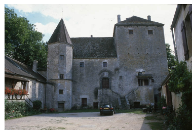
Façade antérieure. Phot. Jean-Luc Duthu IVR26_19992100260ZA
