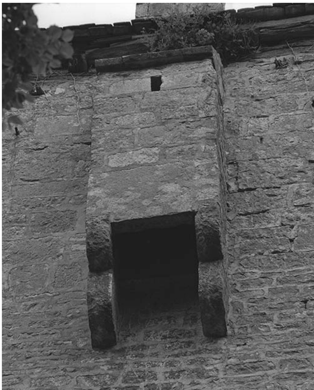
Face droite de la tour : bretèche.
