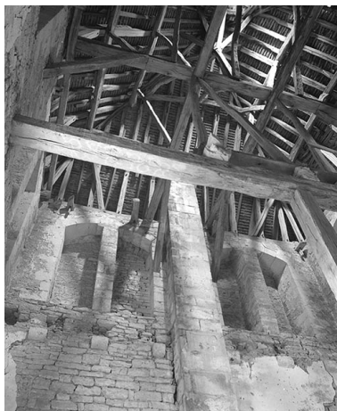
Baies murées de l'étage supérieur et charpente de la tour. Phot. Michel Thierry IVR26_19802100622X
