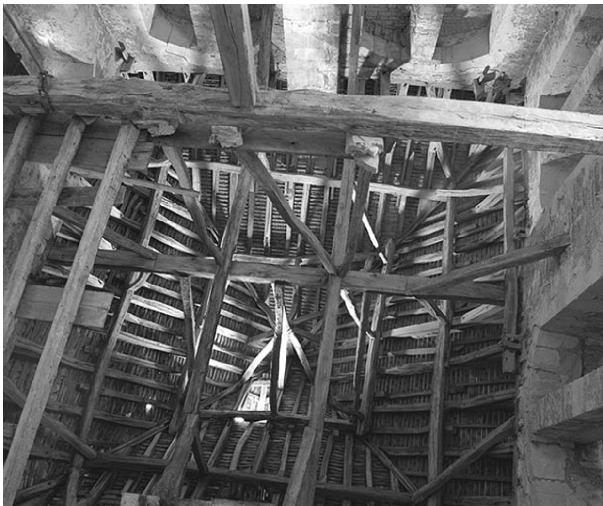
Charpente de la tour.
