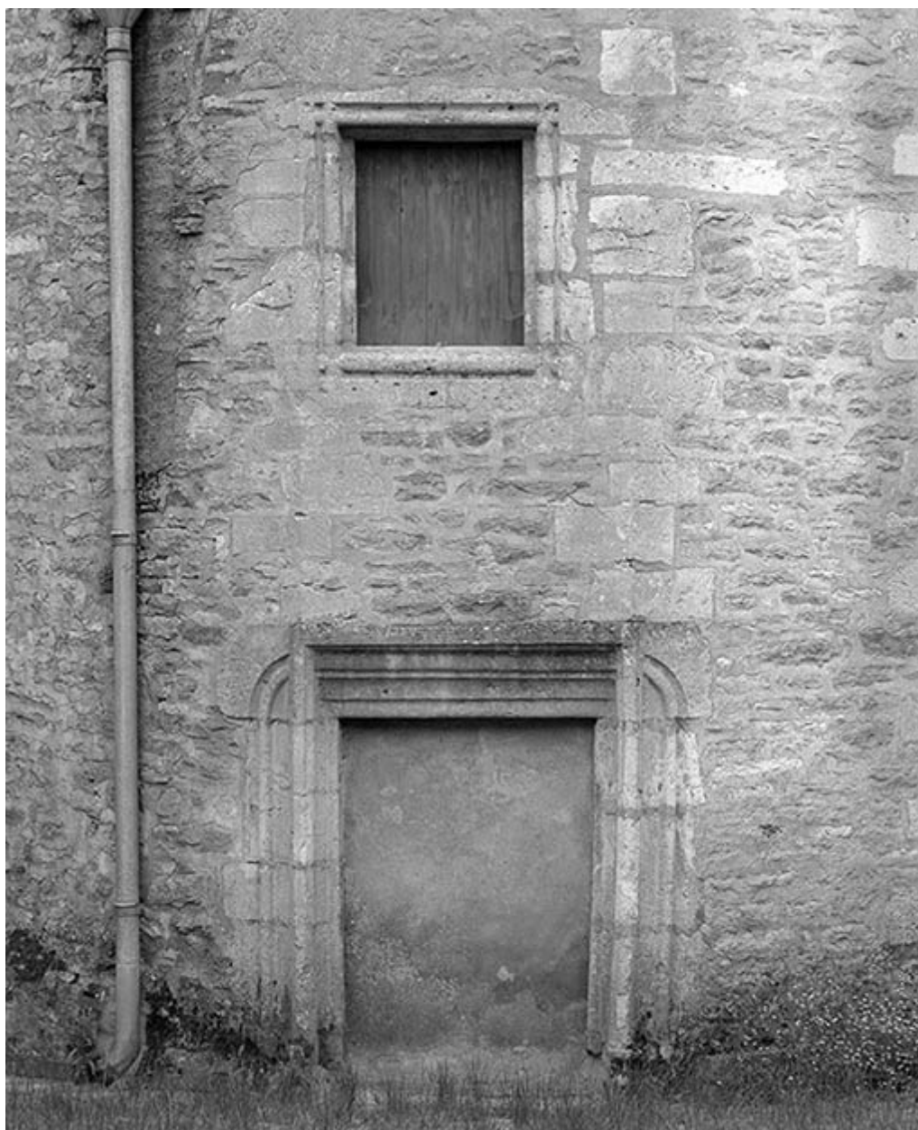
Porte et fenêtre de la tourelle d'escalier.
