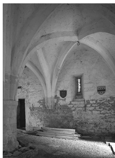
Salle basse de la tour. Phot. Michel Rosso IVR26_19802100602V
