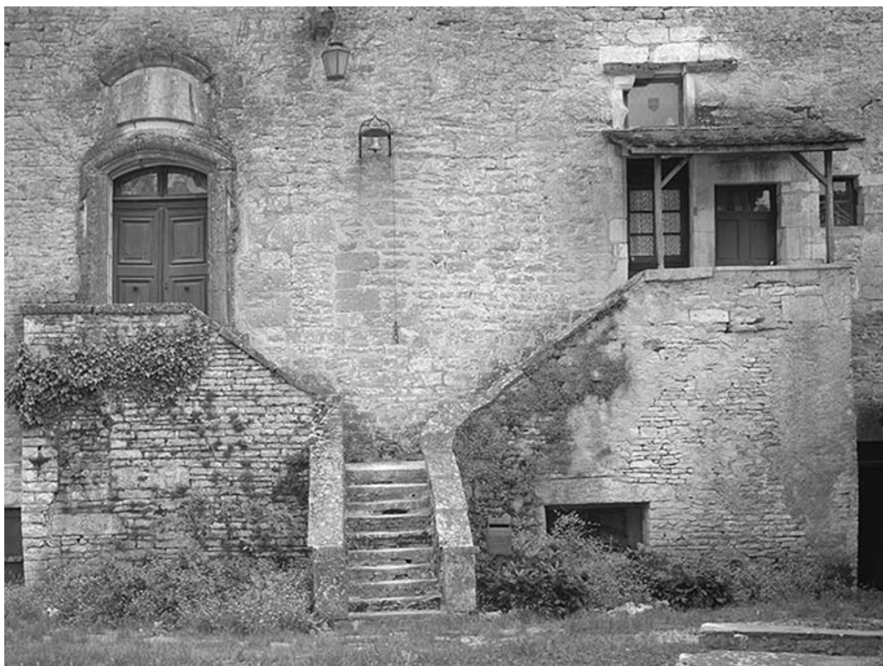
Façade antérieure : escalier desservant l'étage d'habitation.
