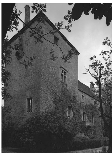
Tour : faces droite et postérieure. Phot. Michel Rosso IVR26_19802100596V
