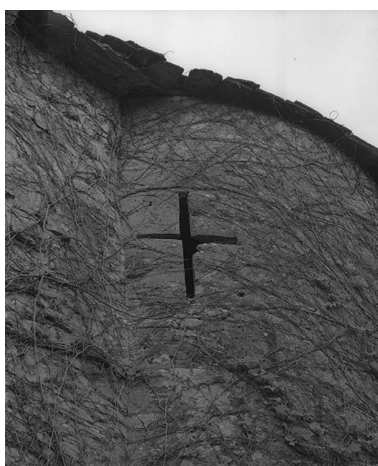
Archère de l'échauguette du corps de logis. Phot. Michel Thierry IVR26_19802100613X
