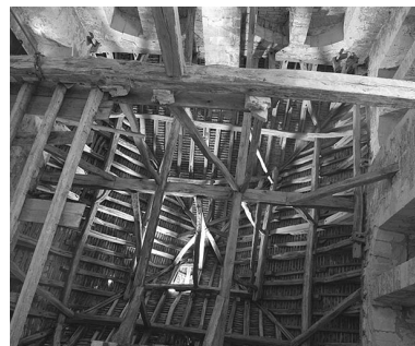
Charpente de la tour. Phot. Michel Thierry IVR26_19802100620X
