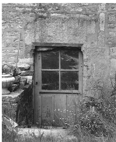
Porte de l'élévation antérieure de l'aile. Phot. Michel Thierry IVR26_19802100607X
