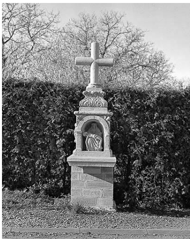
Croix après restauration : de face. Phot. Bernard Lardière IVR43_19847000018X
