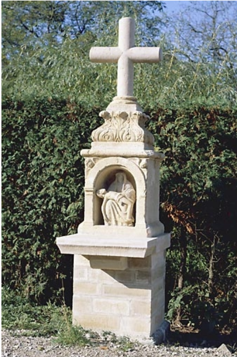
Vue de face après restauration.
