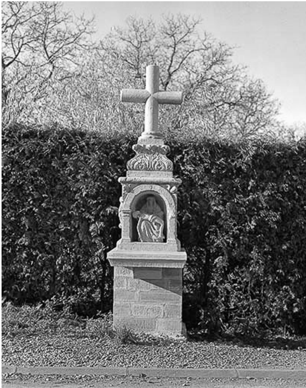
Croix après restauration : de face.
