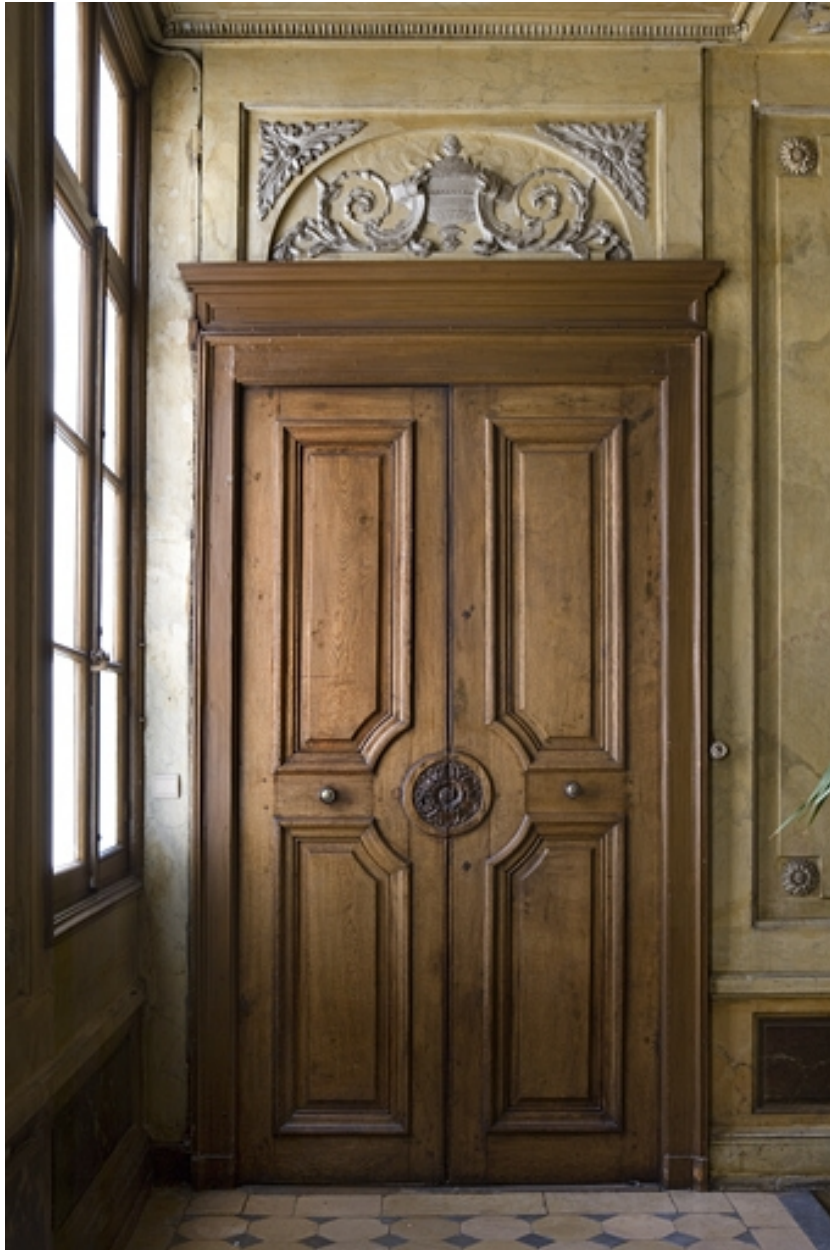
Hôtel en fond de cour, escalier : détail de la porte droite sur le premier palier.
