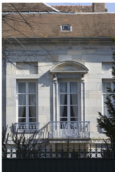
Hôtel en fond de cour : détail de la fenêtre centrale, premier étage sur jardin. Phot. Yves Sancey IVR43_20092501105NUC2A
