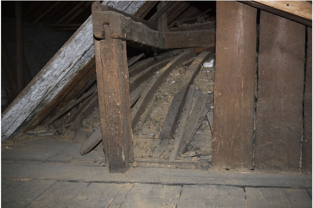
Hôtel en fond de cour : extérieur de la fausse-coupe de l'escalier situé dans le grenier.
