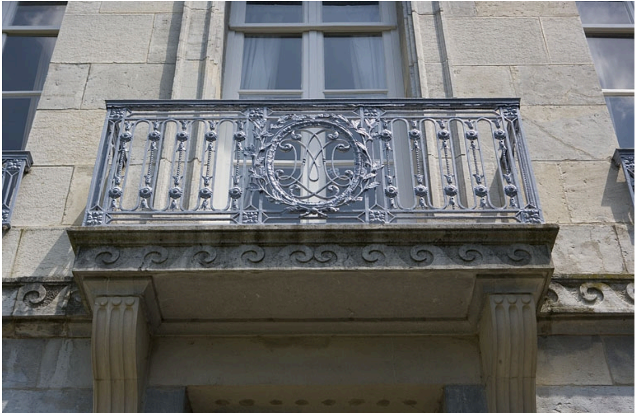
Hôtel en fond de cour : détail du balcon sur la façade postérieure.
