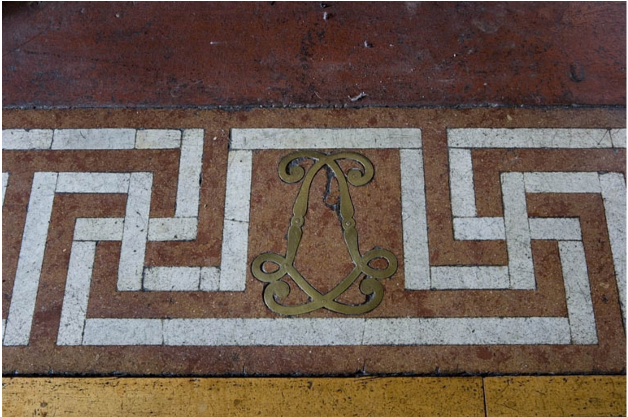
Hôtel en fond de cour : détail central de la dalle de foyer de la cheminée du grand salon.
