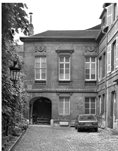
Détail de la façade de l'hôtel en fond de cour. Phot. Yves Sancey IVR43_19802501474V
