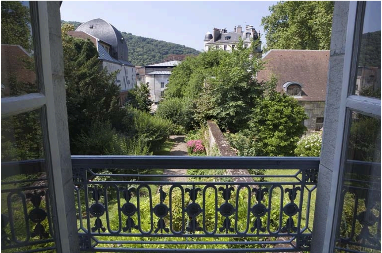
Hôtel en fond de cour : vue du jardin depuis le premier étage, avec le garde-corps de la fenêtre.
