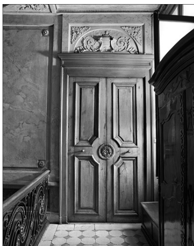
Détail de la porte d'entrée du premier étage de l'hôtel.
