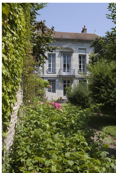
Hôtel en fond de cour : vue d'ensemble de la façade postérieure depuis le fond du jardin. Phot. Yves Sancey IVR43_20092501123NUC2A
