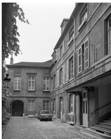
Vue d'ensemble des façades sur cour de l'hôtel. Phot. Yves Sancey IVR43_19802501473V
