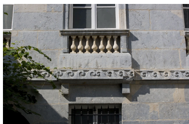
Hôtel en fond de cour : détail d'un balcon et de la frise au premier étage de la façade antérieure. Phot. Yves Sancey IVR43_20092501065NUC2A
