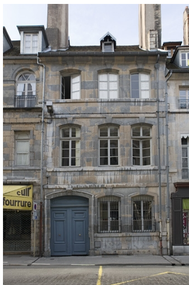
Façade sur rue, de face. Phot. Yves Sancey IVR43_20092501061NUC2A
