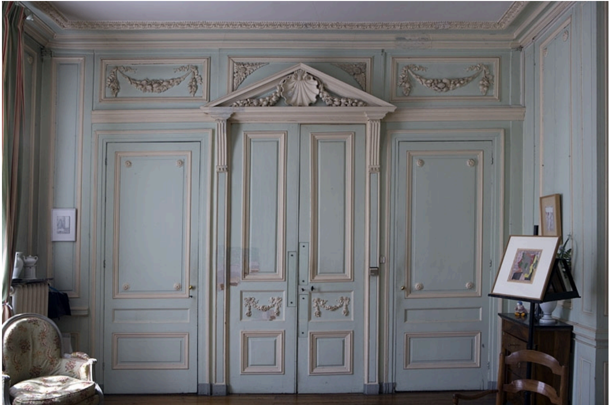
Hôtel en fond de cour, chambre à droite de l'antichambre (ancien petit salon) : lambris et porte donnant sur l'antichambre.
