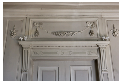
Hôtel en fond de cour, antichambre : décor du dessus d'une fausse-porte. Phot. Yves Sancey IVR43_20092501081NUC2A
