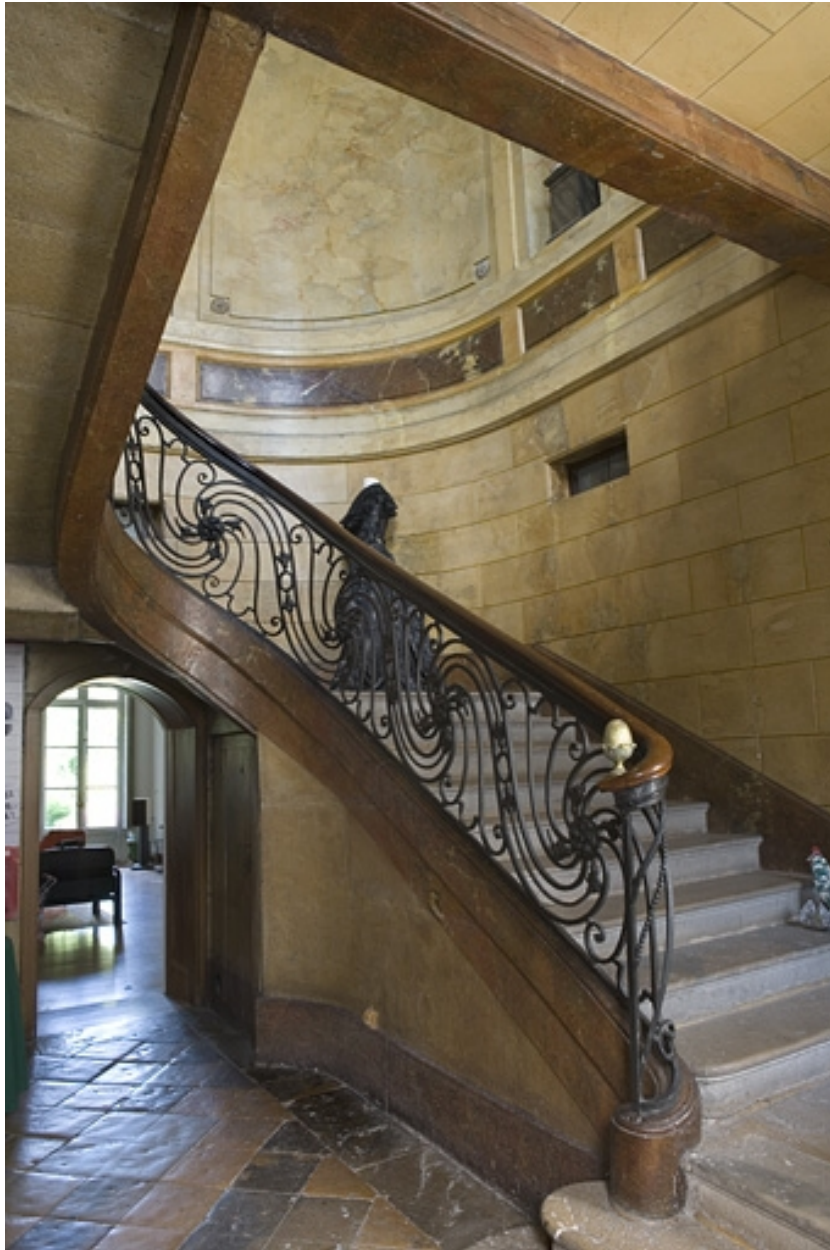
Hôtel en fond de cour, escalier : détail de la première volée avec la rampe en ferronnerie.
