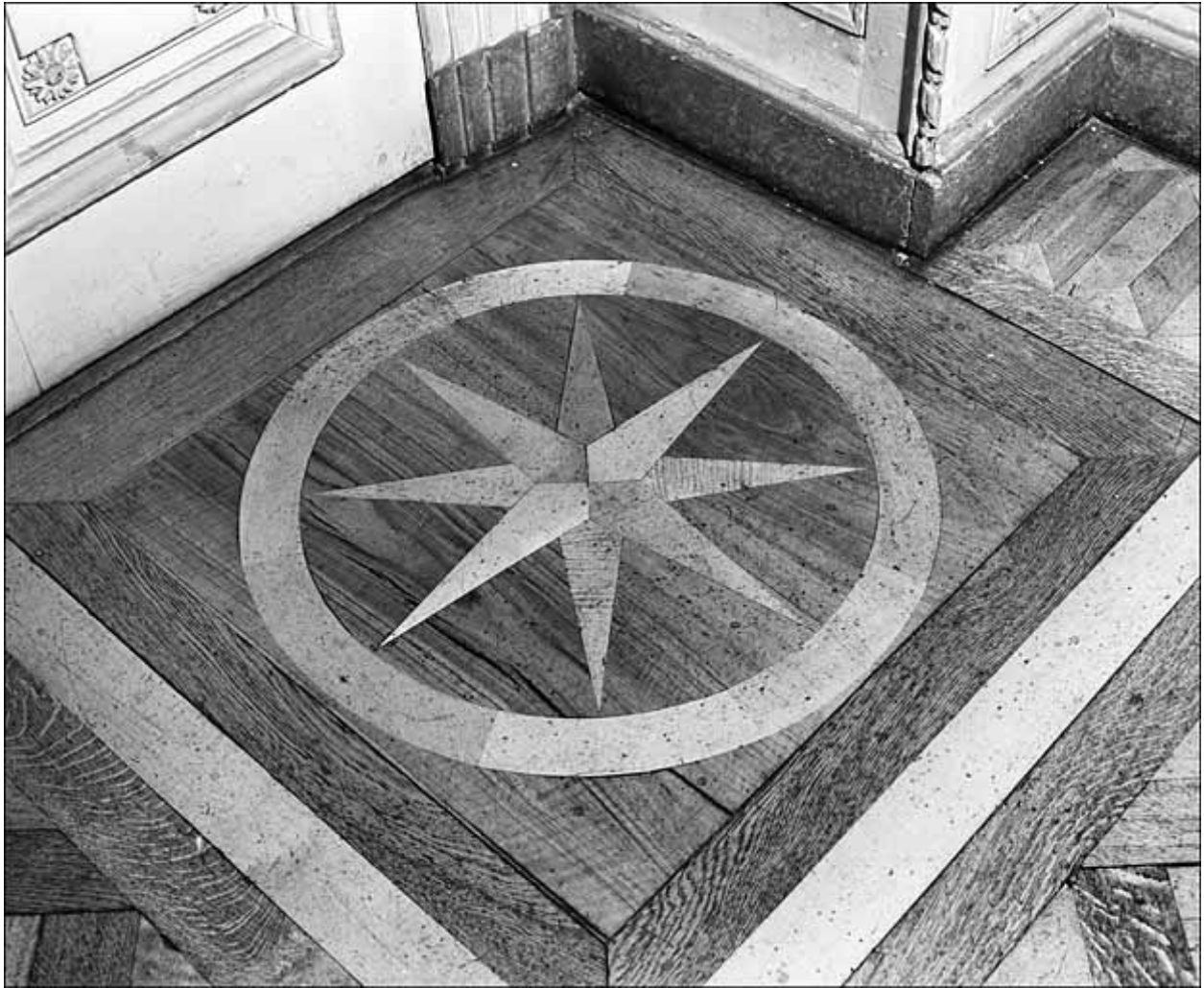
Détail d'un décor du parquet en marquetterie du grand salon.
