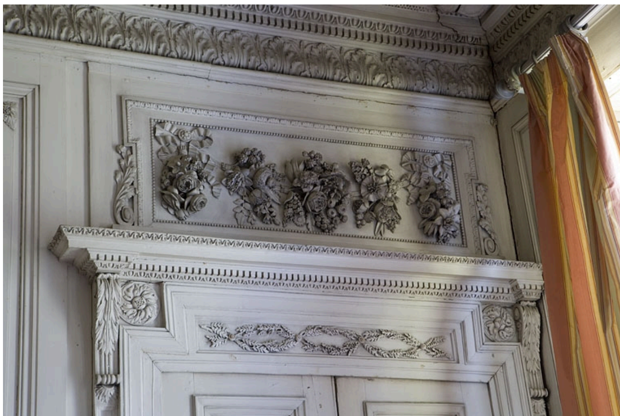
Hôtel en fond de cour : détail du dessus de porte entre le grand salon et la chambre.
