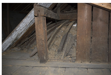
Hôtel en fond de cour : extérieur de la fausse-coupole de l'escalier situé dans le grenier. Phot. Yves Sancey IVR43_20092501119NUC2A
