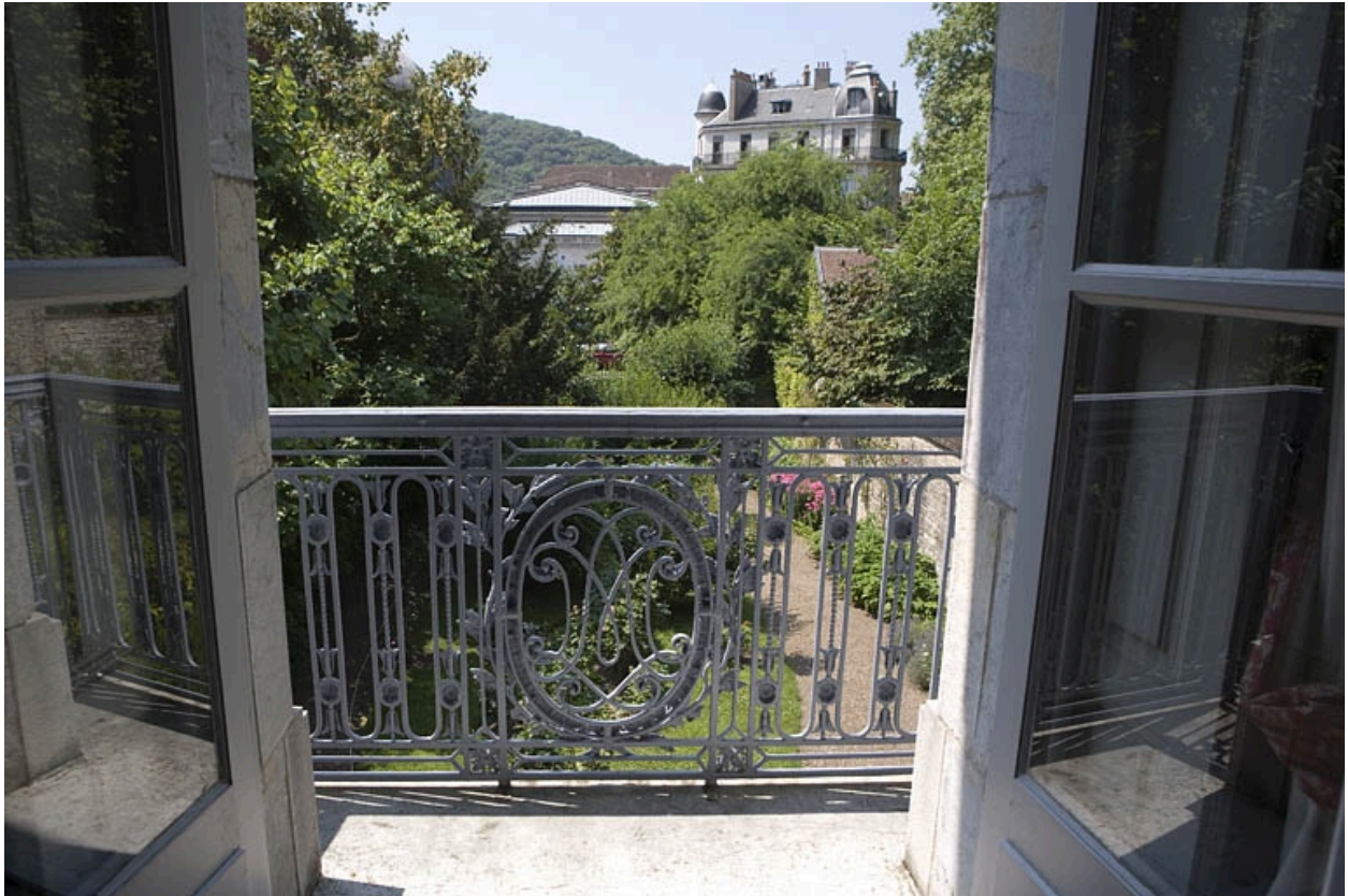
Hôtel en fond de cour : détail de la grille du balcon donnant sur le jardin, depuis l'intérieur.
