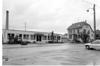
Bureaux et logement depuis le nord. Phot. Yves Sancey IVR43_200290000424X
