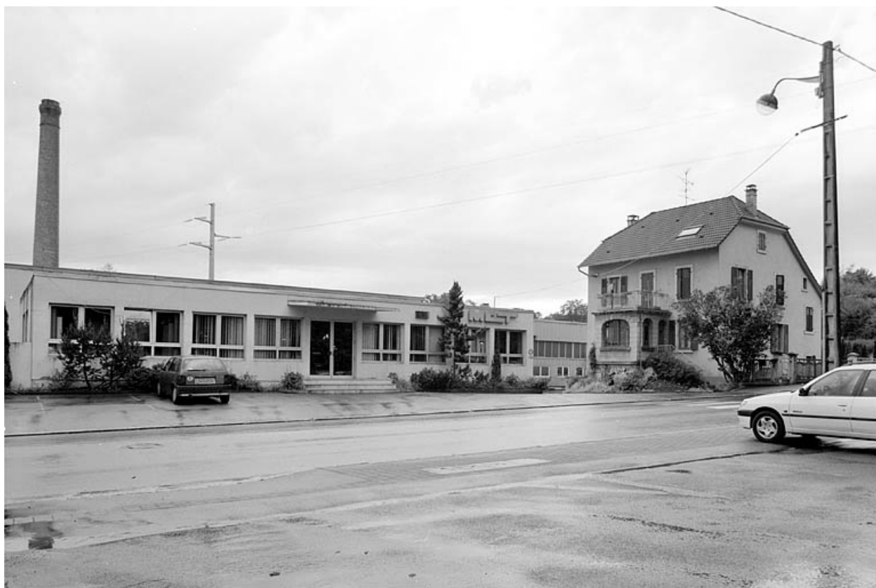
Bureaux et logement depuis le nord.
