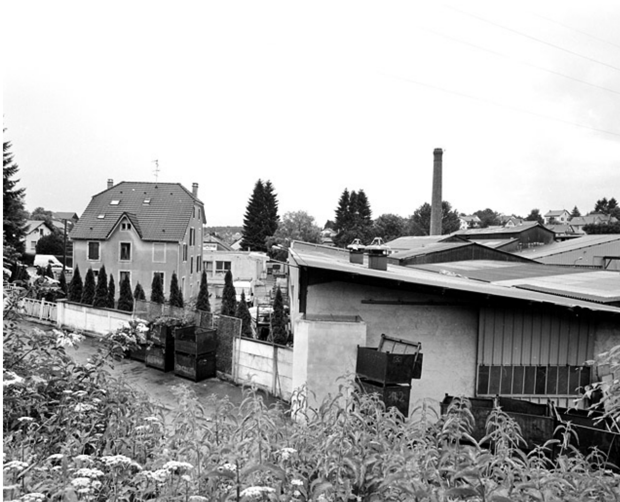
Logement et ateliers de fabrication.
