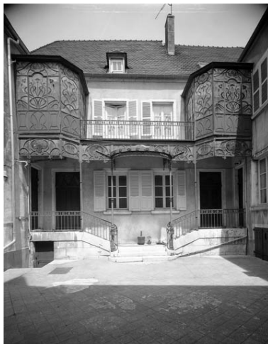
Façade antérieure sur cour, de face. Phot. Yves Sancey IVR43_19917000064V
