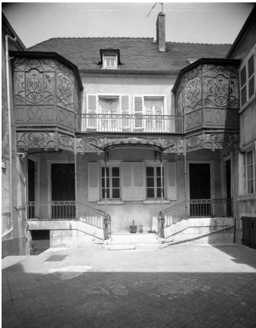
Façade antérieure sur cour, de face.
