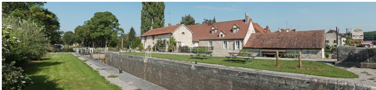
Vue d'ensemble du site d'écluse.
