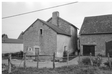
Façade postérieure et latérale droite. Phot. Jean- Marie NEPASUTILISERBaverel
