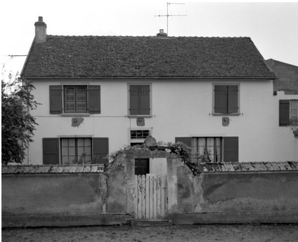
Façade postérieure sur jardin d'une maison (ancien presbytère).
