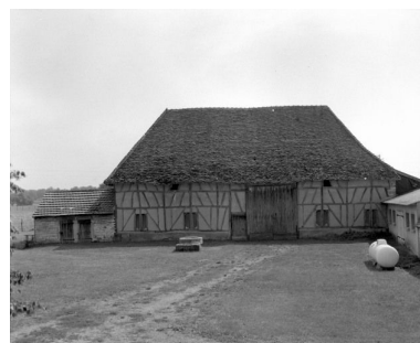
Bâtiment des dépendances d'une ferme située au lieu-dit La Villeneuve. Phot. Michel Rosso IVR26_19867100049X
