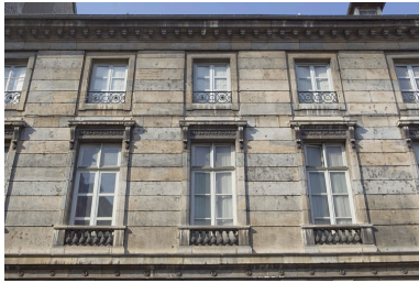
Façade antérieure : détail des premier et deuxième étages. Phot. Yves Sancey IVR43_20102500989NUC2A
