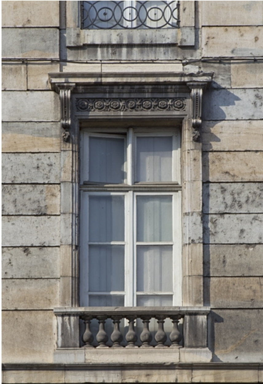
Façade antérieure : détail d'une fenêtre du premier étage.
