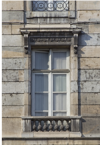
Façade antérieure : détail d'une fenêtre du premier étage. Phot. Yves Sancey IVR43_20102500990NUC2A
