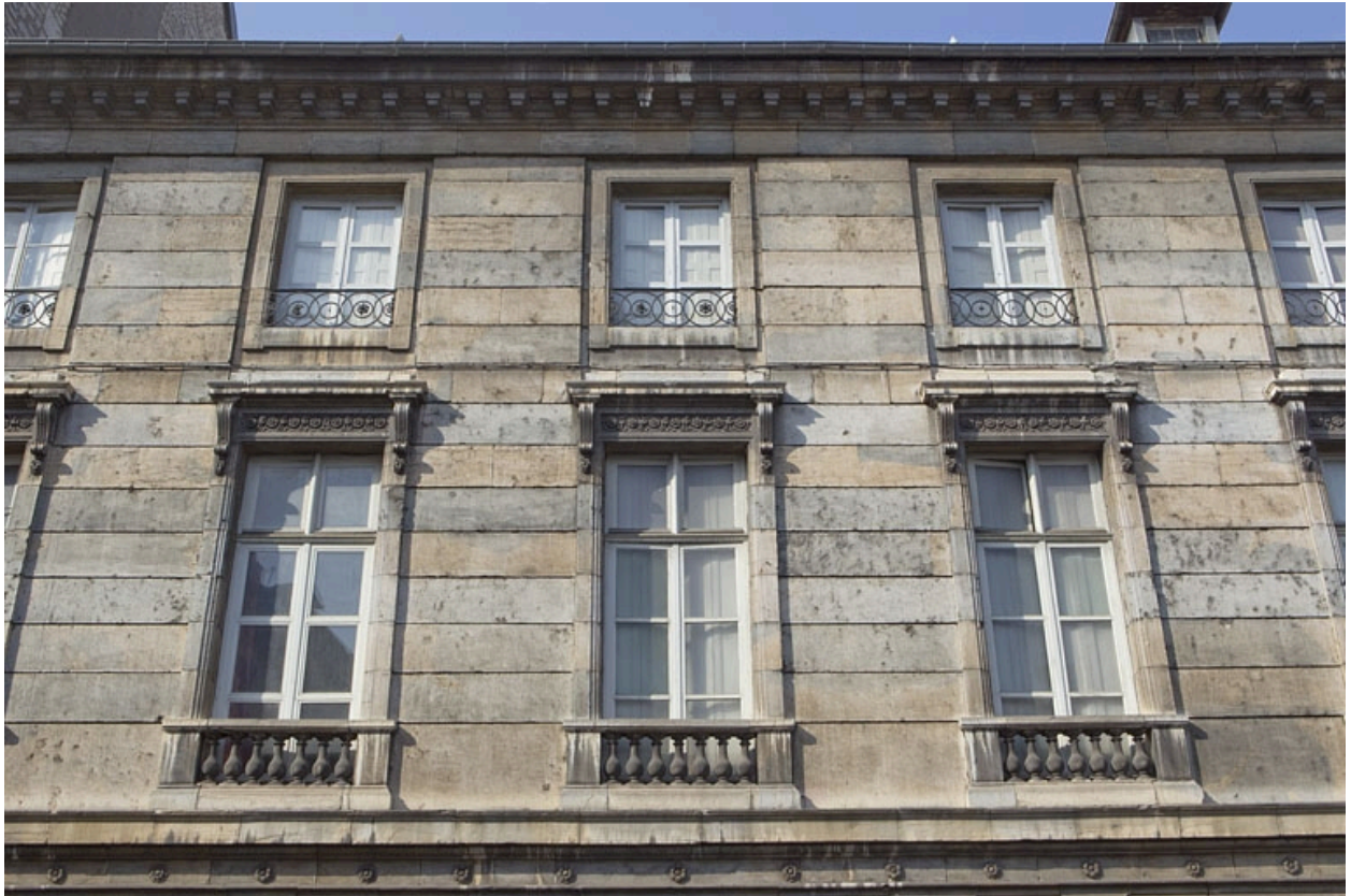
Façade antérieure : détail des premier et deuxième étages.
