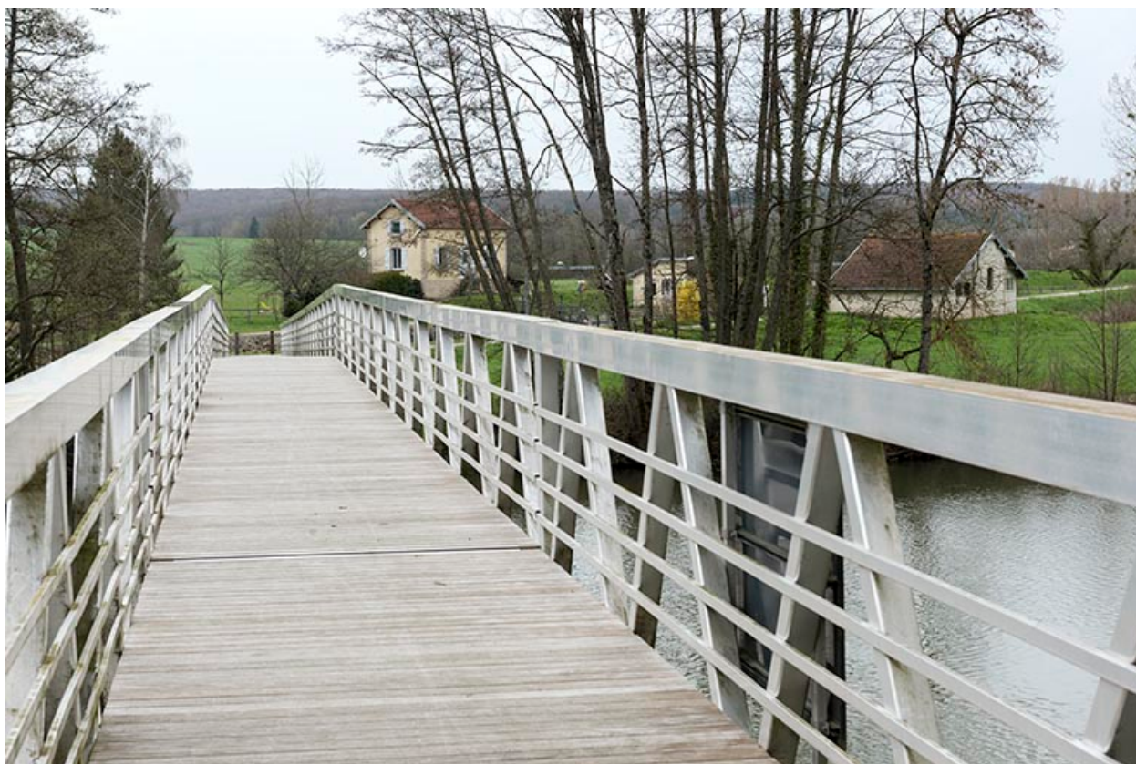
Passerelle enjambant la Saône. Vue de dessus.
