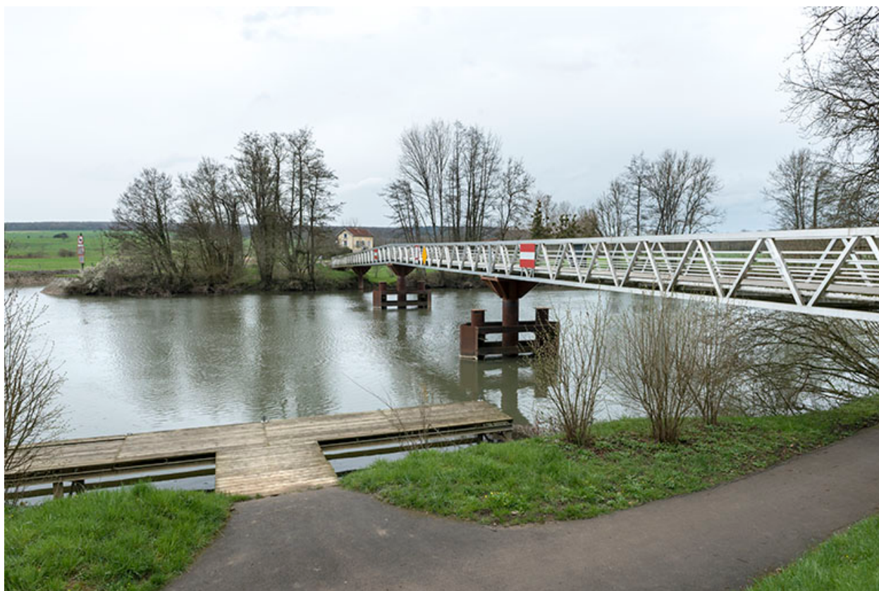
Passerelle enjambant la Saône.
