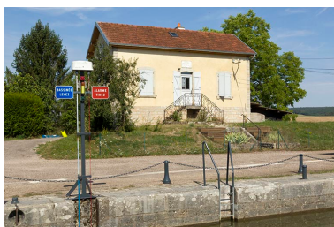
Vue de face de la maison d'éclusier. Phot. Sonia Dourlot IVR43_20157000769NUC2A
