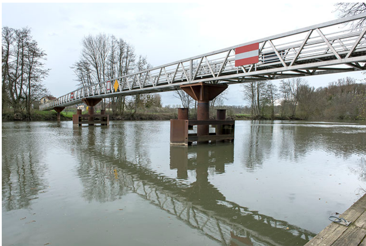
Passerelle enjambant la Saône.
