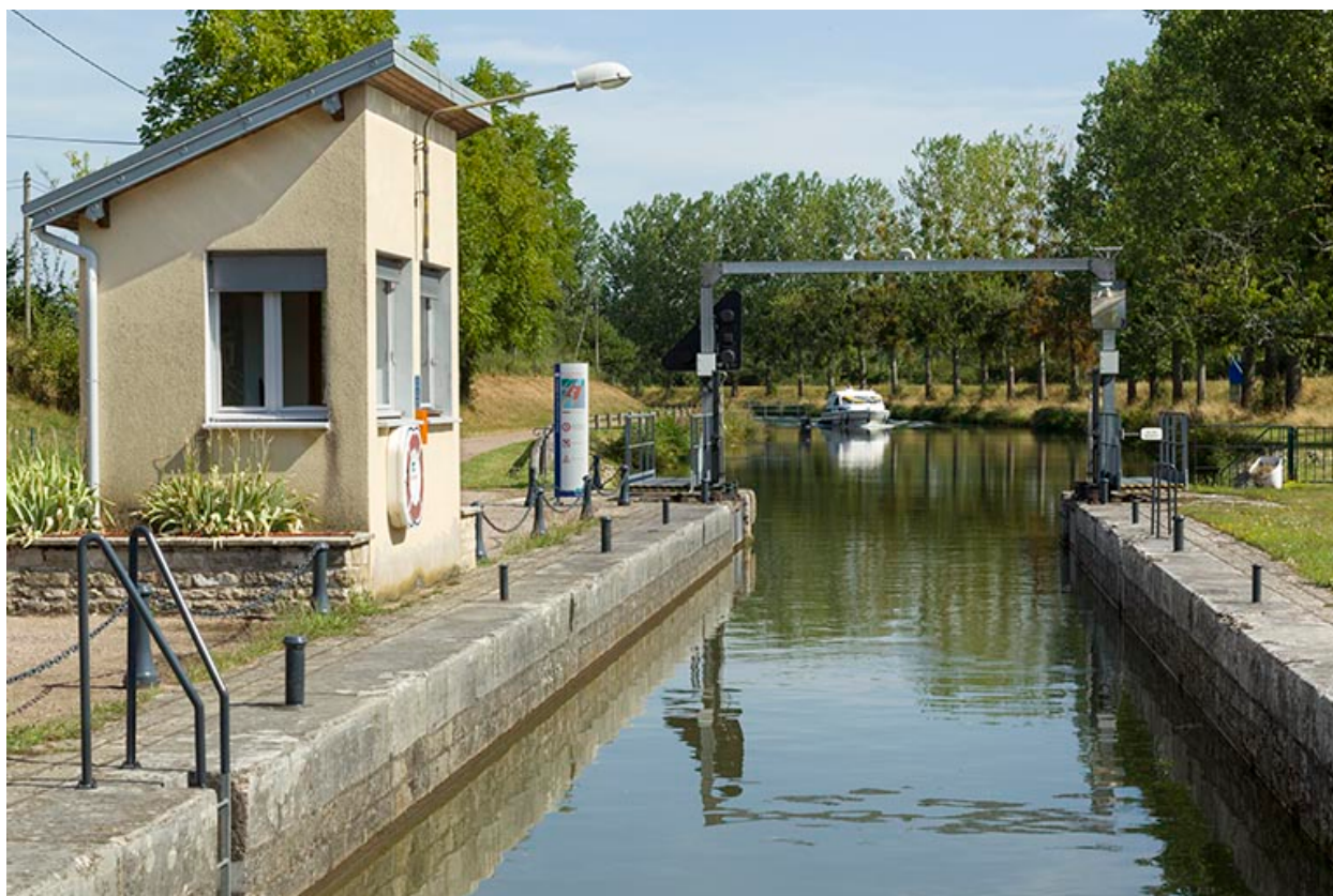
Poste de commande et un bateau montant se présentant devant le sas de l'écluse ouverte.
