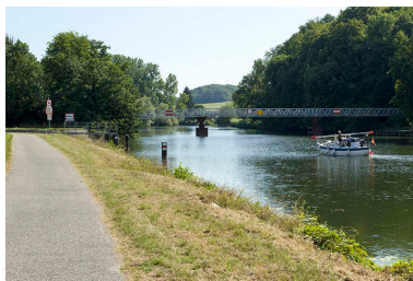
En aval de l'écluse un bateau montant et passerelle enjambant la Saône. Phot. Sonia Dourlot IVR43_20157000774NUC2A
