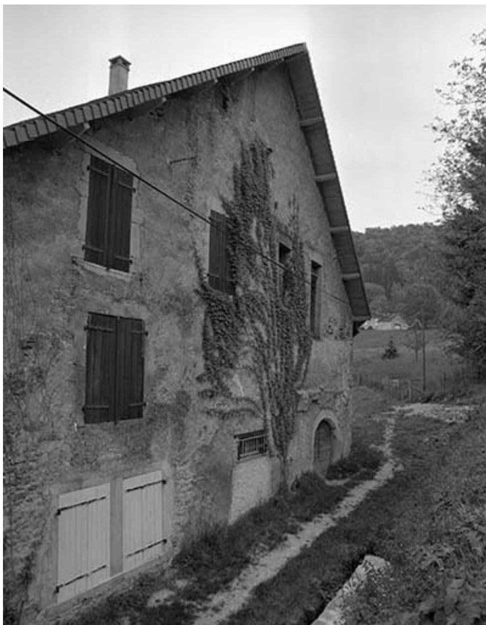
Façade latérale droite.
