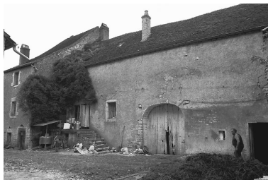
Vue des parties agricoles. Phot. Bernard Lardière IVR43_19817000462Z
