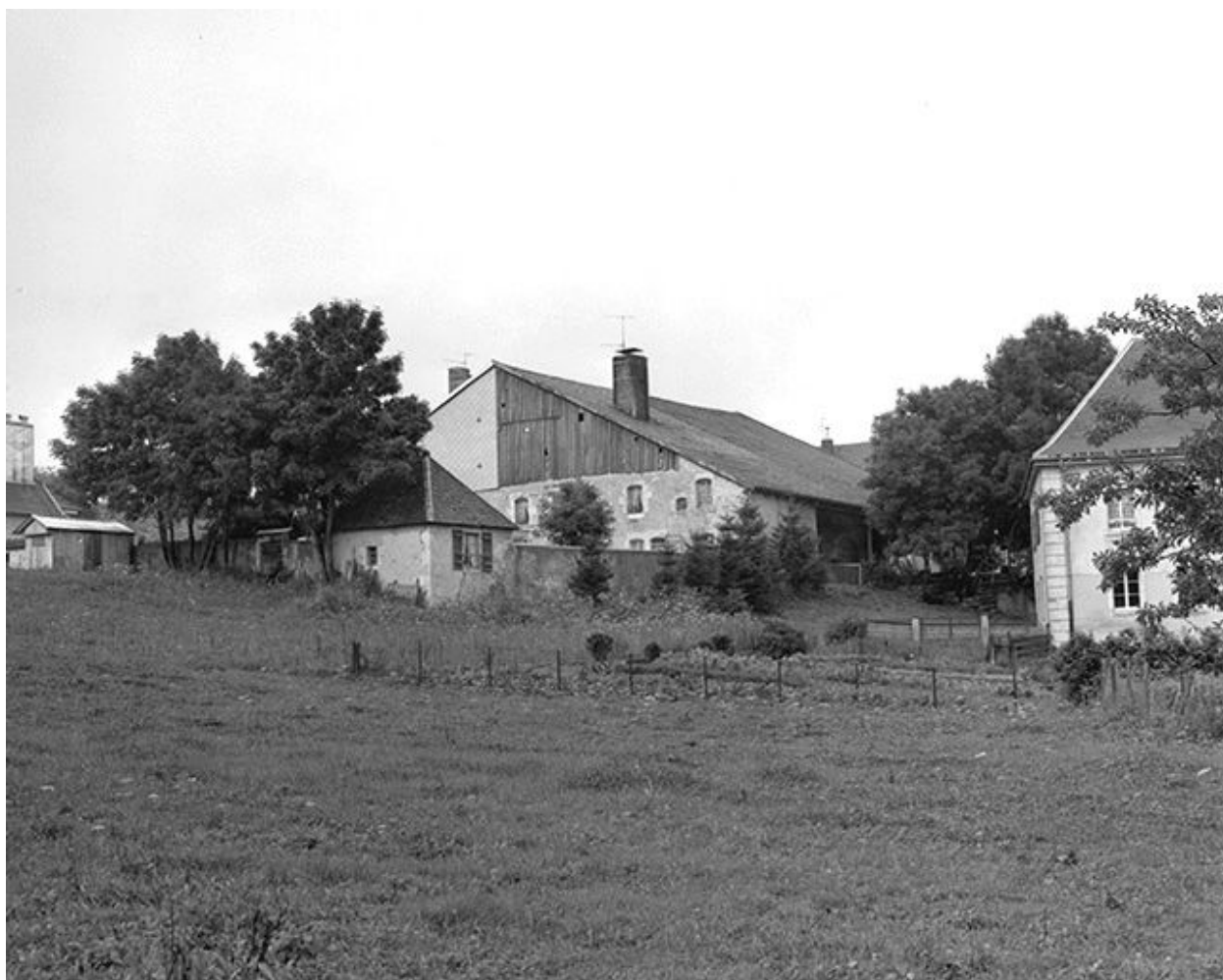
Ferme à Bonnevaux.
