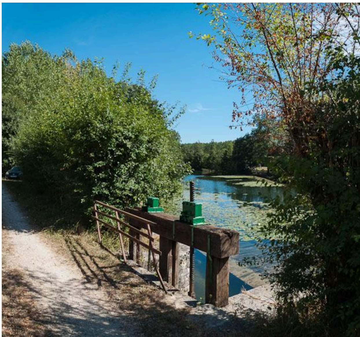
Détail des vannes.
