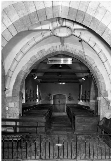
Vue intérieure prise du chœur Phot. Jean-Luc Duthu IVR26_19852100777V
