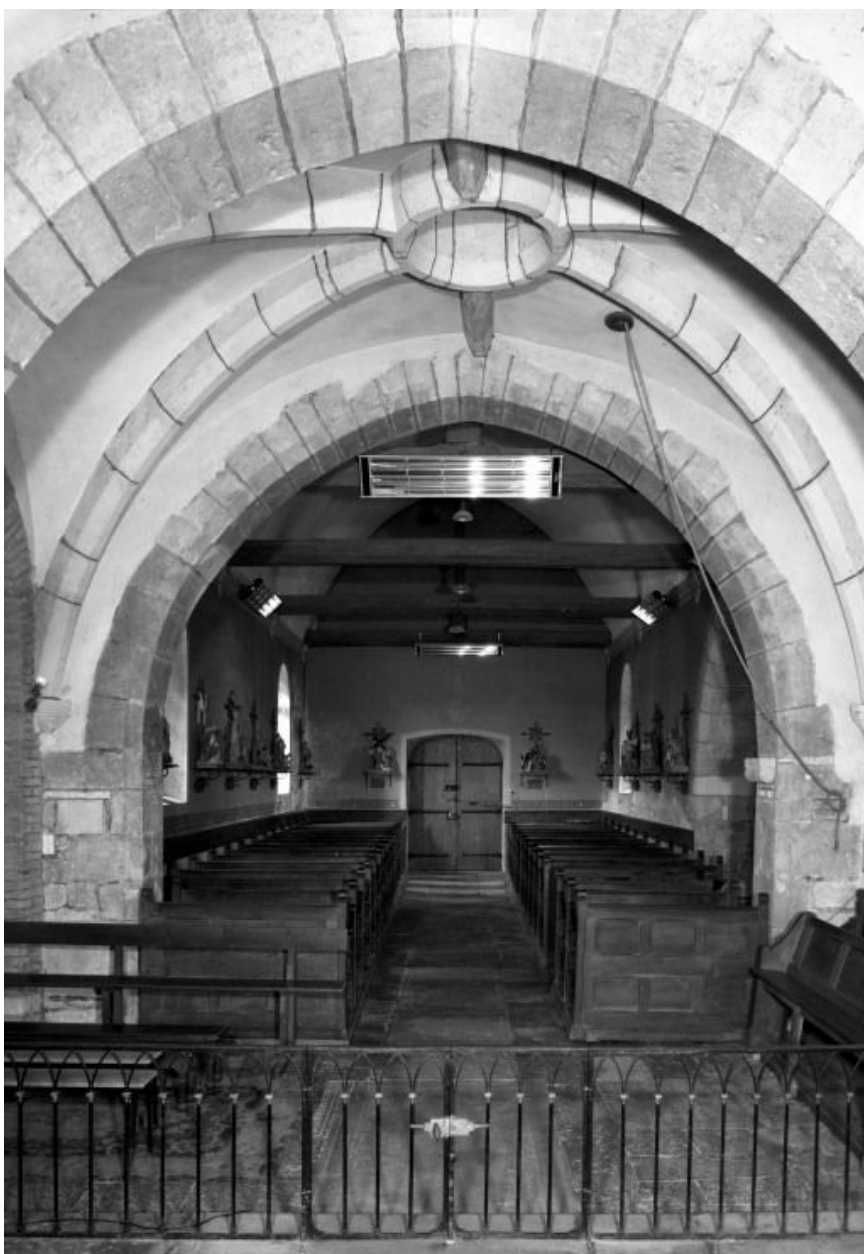
Vue intérieure prise du chœur
