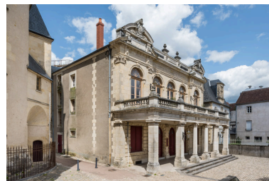
Façade antérieure et porche, de trois quarts gauche. Phot. Pierre-Marie Barbe-Richaud IVR26_20235800260NUC4A
