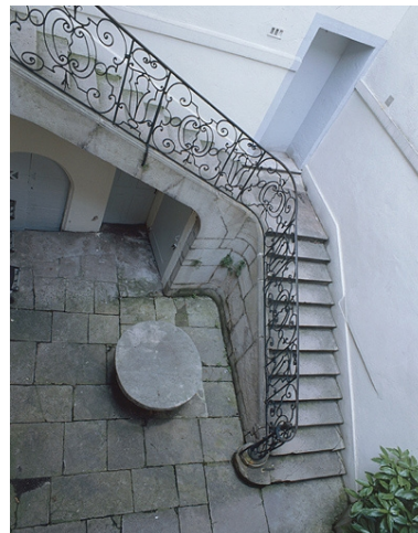
L'escalier dans la cour. Phot. Yves Sancey IVR43_19883900098XA
