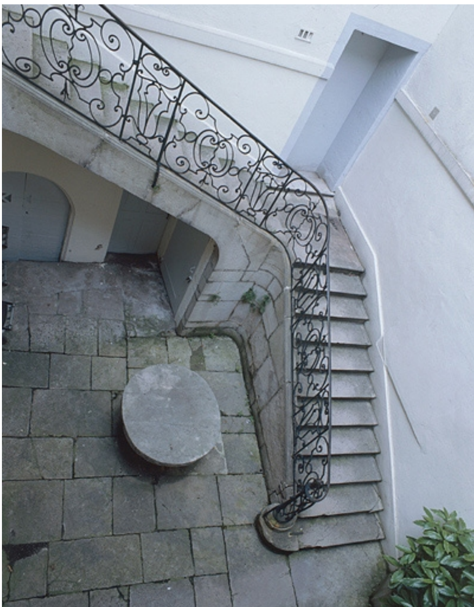
L'escalier dans la cour.
