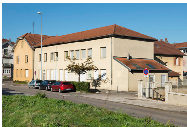
Vue depuis l'est. Phot. Jérôme Mongreville IVR43_20172501316NUC4A
