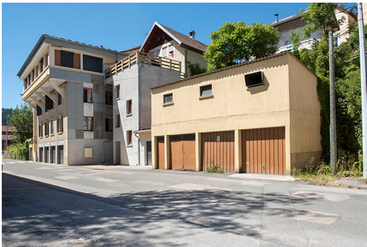
Site ancien, vu du nord.
