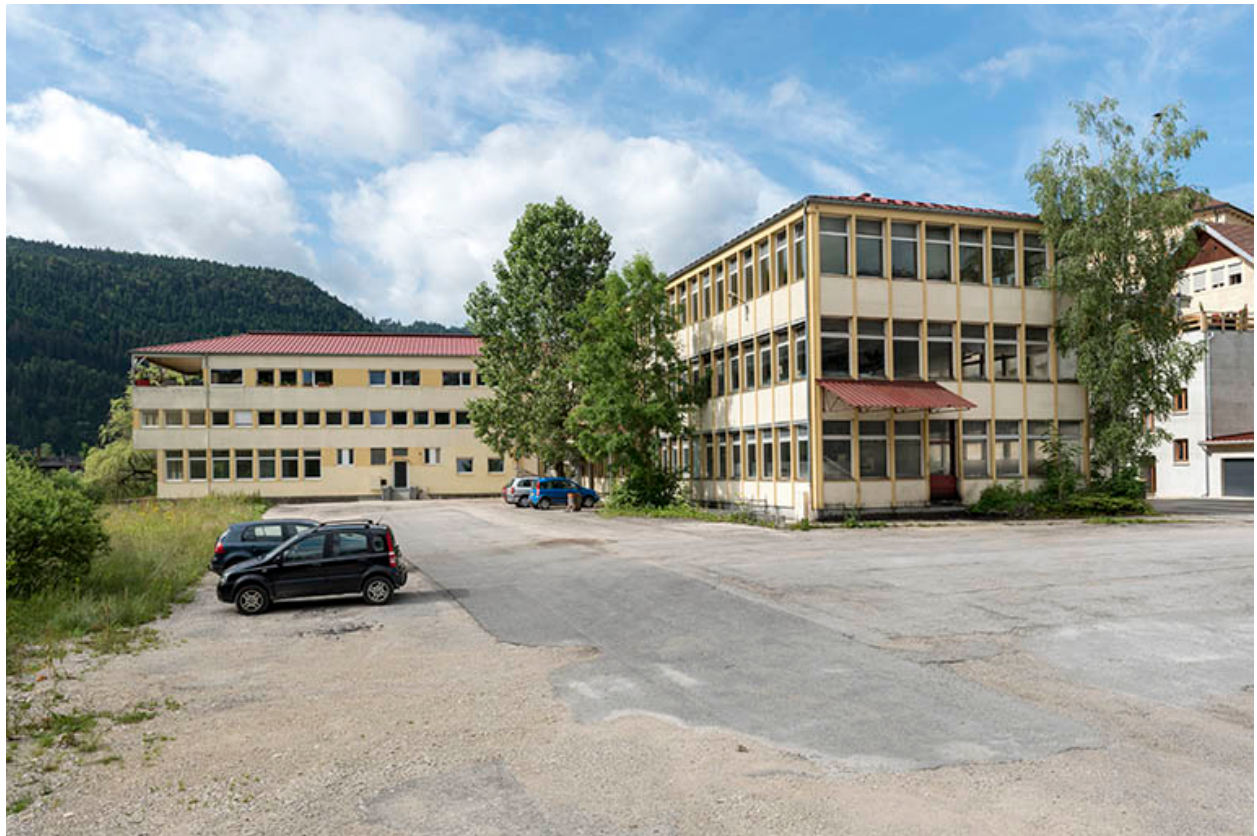
Site récent, vu du nord.
