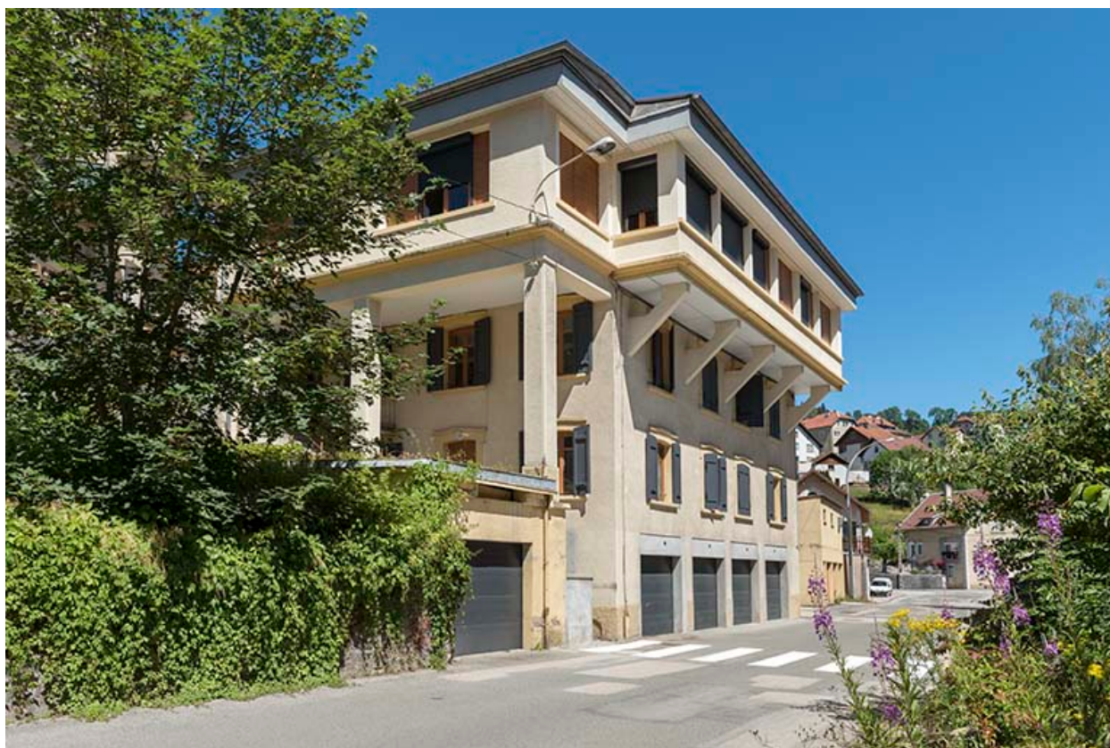
Site ancien, vu du sud.
