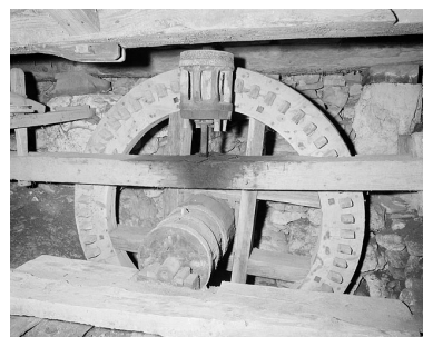
Rouet et lanterne en liaison avec la meule.
