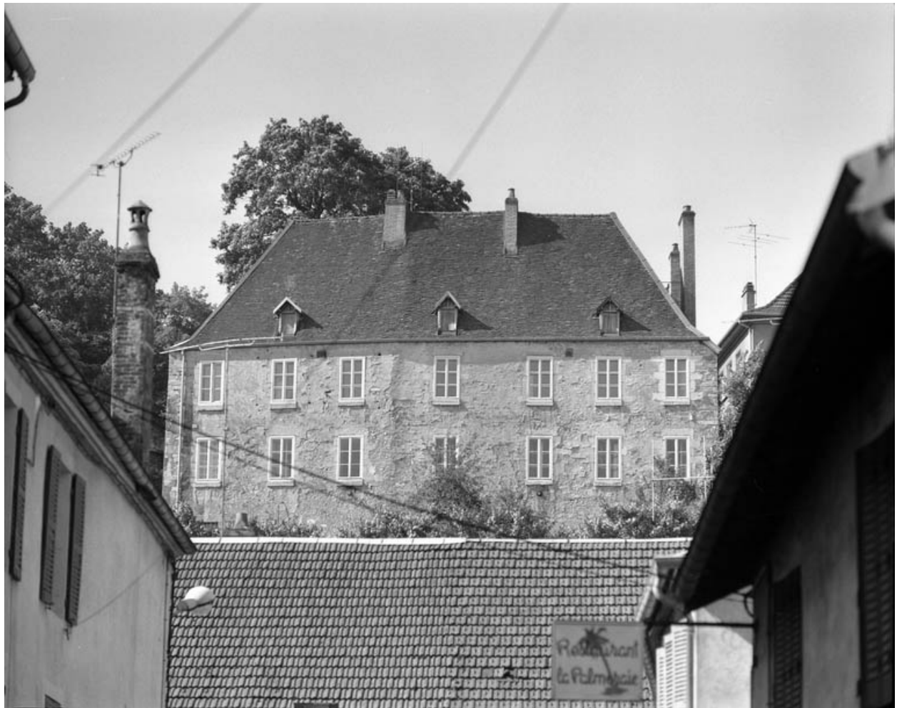
Façade postérieure, de face.
