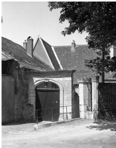
Le portail d'entrée de la cour. Phot. Yves Sancey IVR43_19897000410X
