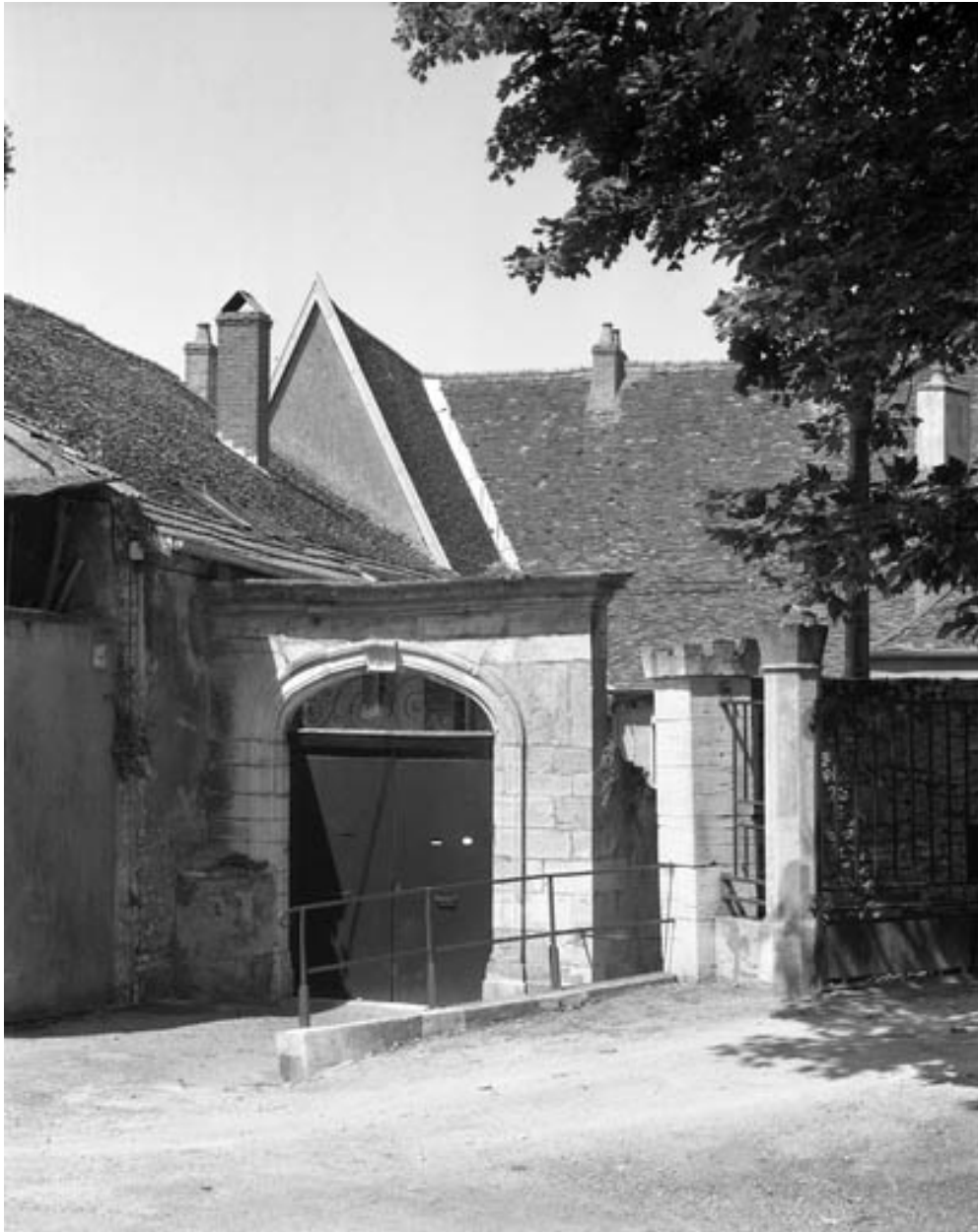
Le portail d'entrée de la cour.
