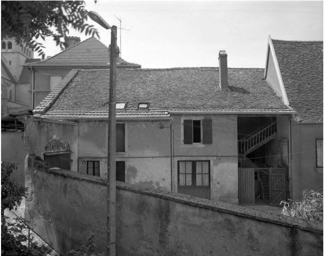
Façade antérieure du logement sur cour.
