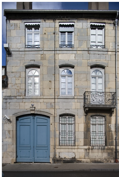
Vue d'ensemble de la façade sur rue : de face. Phot. Yves Sancey IVR43_20072500203NUCA
