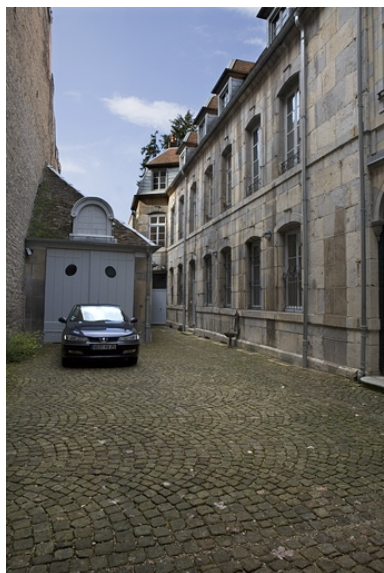
Vue d'ensemble de l'aile sur cour et du bâtiment des remise et écurie. Phot. Yves Sancey IVR43_20072500209NUCA
