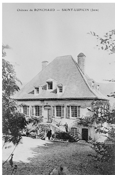
Façade principale du château de Ronchaud. Phot. Jérôme Mongreville, Autr. Daniel Lançon IVR43_19963901714X
