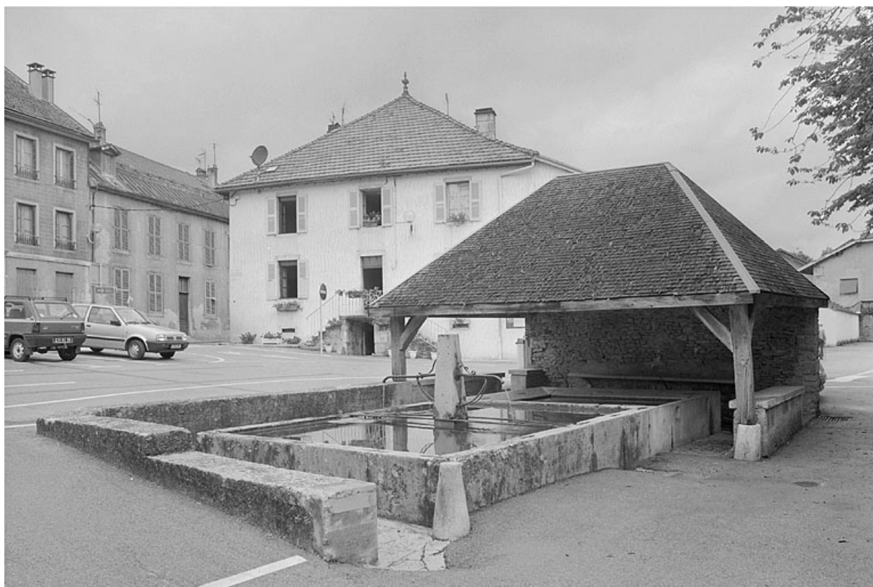
Place de la fontaine, la fontaine-lavoir.
