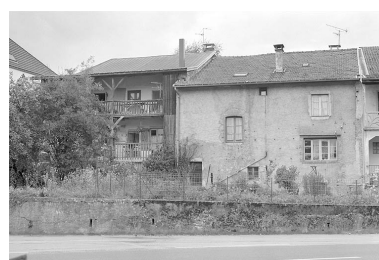
Grande Rue, façades postérieures d'anciennes fermes. Phot. Jérôme Mongreville IVR43_19963901163X
