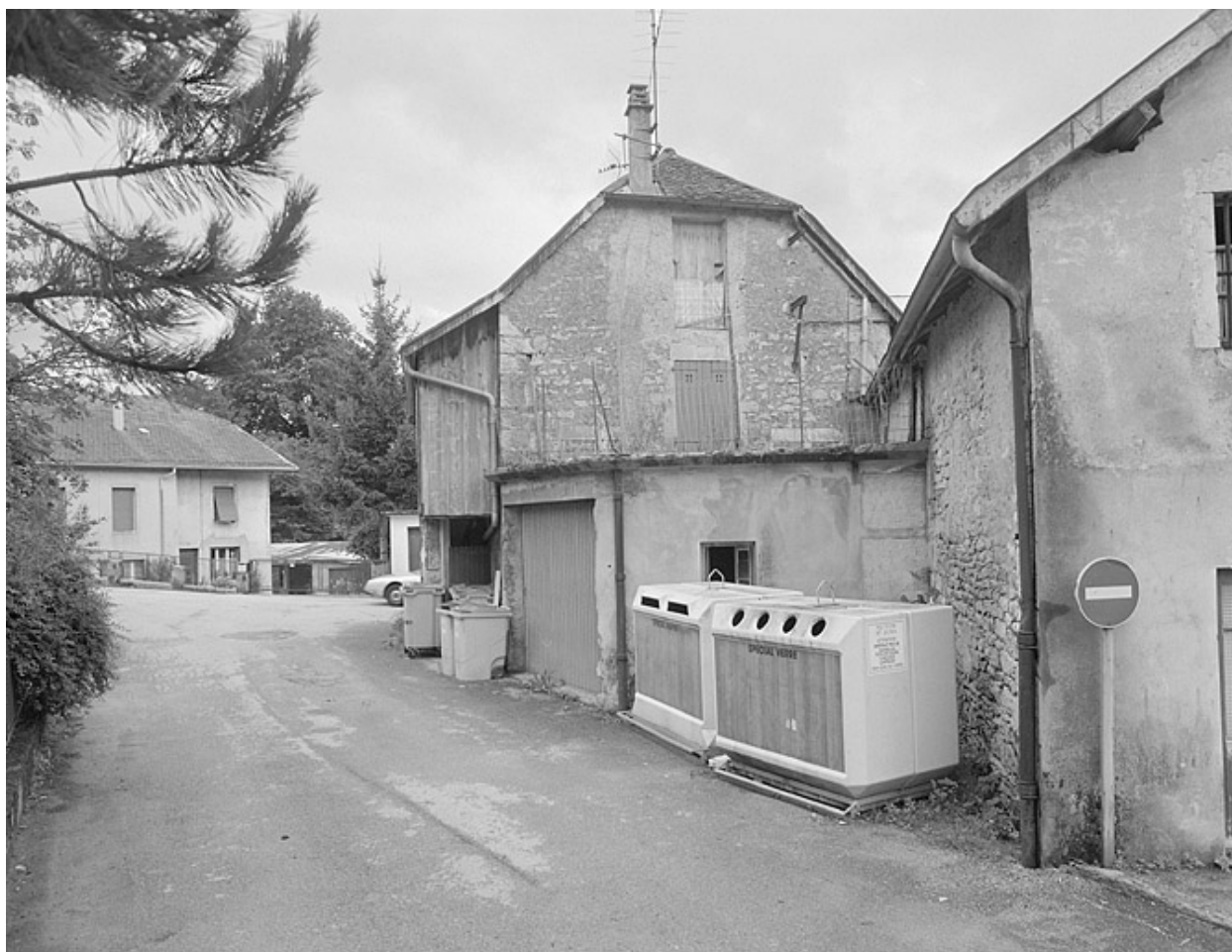
Face droite de l'ancienne fromagerie.
