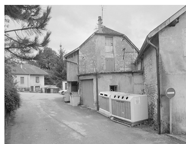
Face droite de l'ancienne fromagerie.
