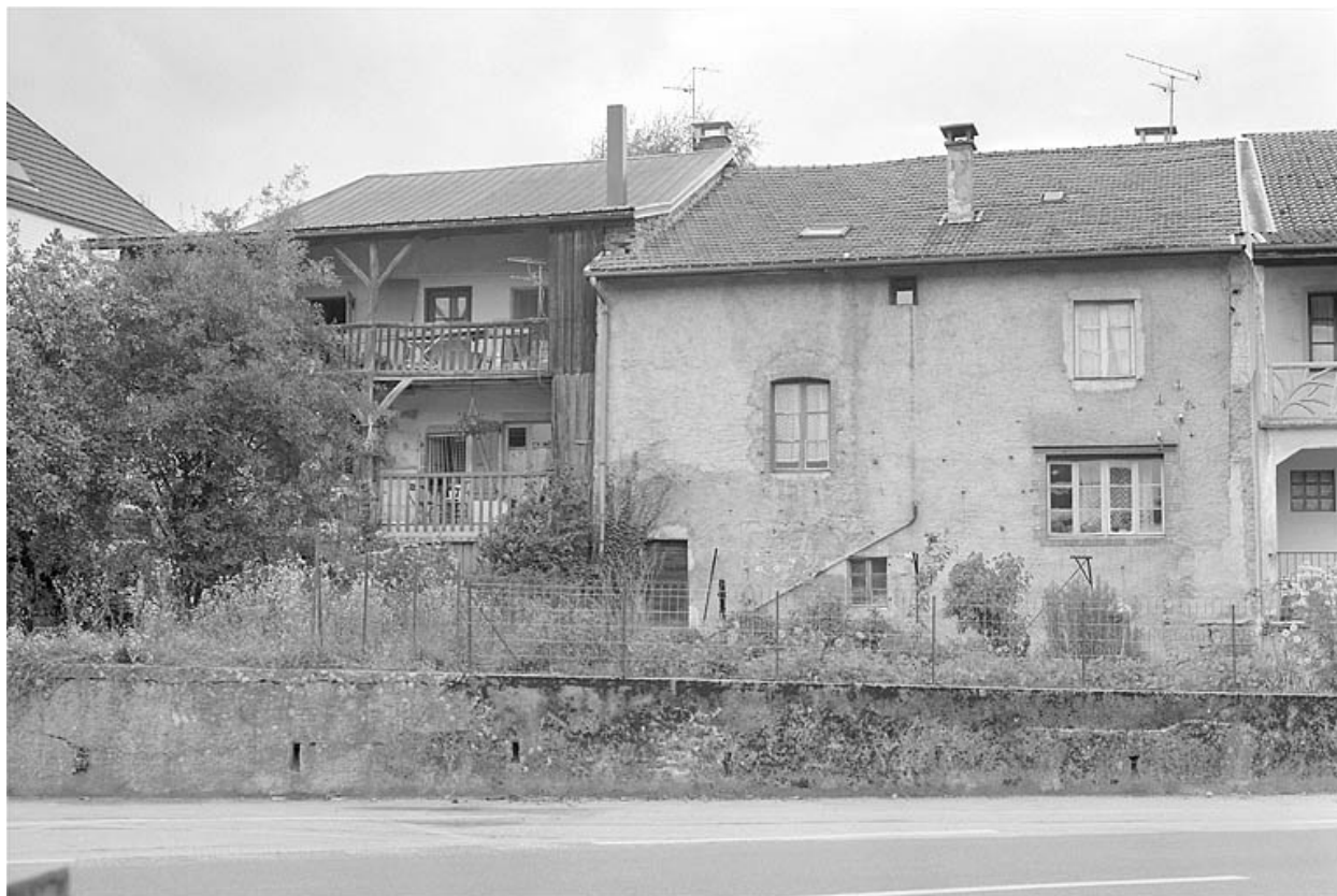
Grande Rue, façades postérieures d'anciennes fermes.
