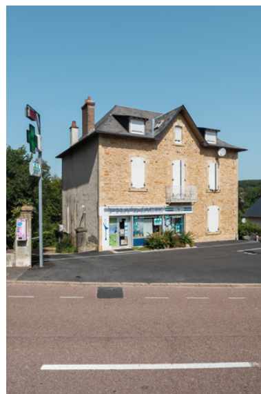
Façade de la villa après sa transformation. Phot. Pierre-Marie Barbe-Richaud IVR26_20195800517NUC4A
