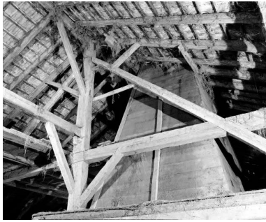
Intérieur : charpente et conduit du "tué". Phot. Yves Sancey IVR43_19772500422X
