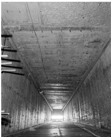
Intérieur : conduit du "tué". Phot. Yves Sancey IVR43_19772500420X
