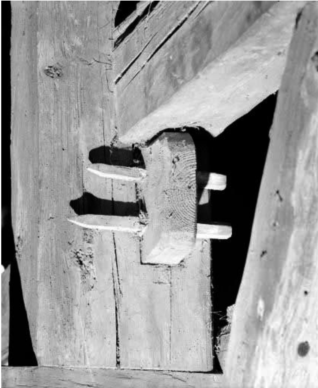
Détail : assemblage de charpente.
