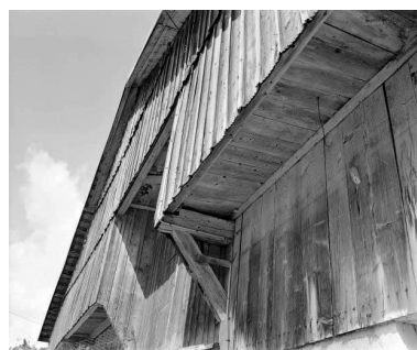
Détail : débord de la "lambrechure" sur le pignon antérieur. Phot. Yves Sancey IVR43_19772500416X
