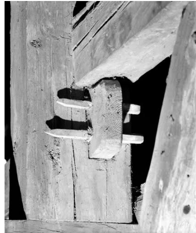
Détail : assemblage de charpente. Phot. Yves Sancey IVR43_19772500418X
