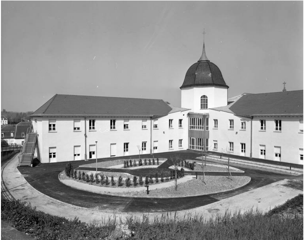
Cour à l'arrière de l'édifice : vue rapprochée.
