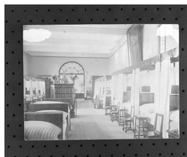
Intérieur de la salle Saint Martin. Phot.
