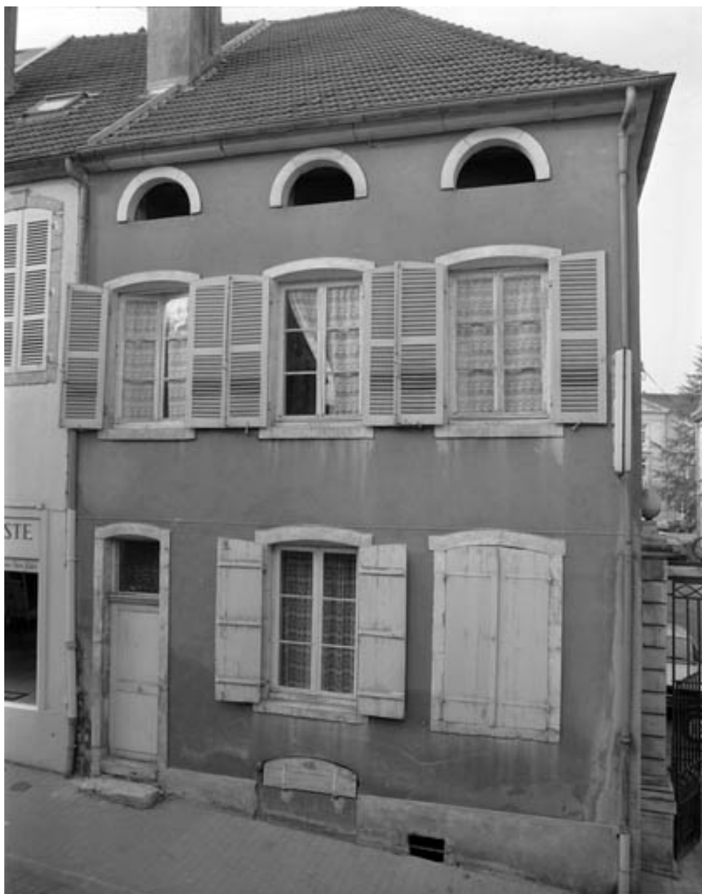
Logement de l'aumônier : façade antérieure de face.
