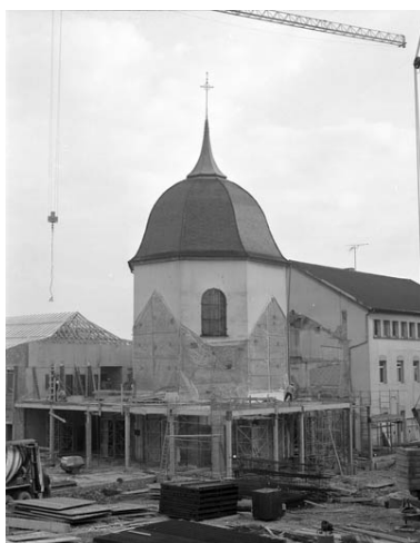
Chapelle en gros plan depuis la cour donnant rue de l'Arsenal pendant les travaux de démolition de l'année 1989. Phot. Yves Sancey IVR43_19897000112X
