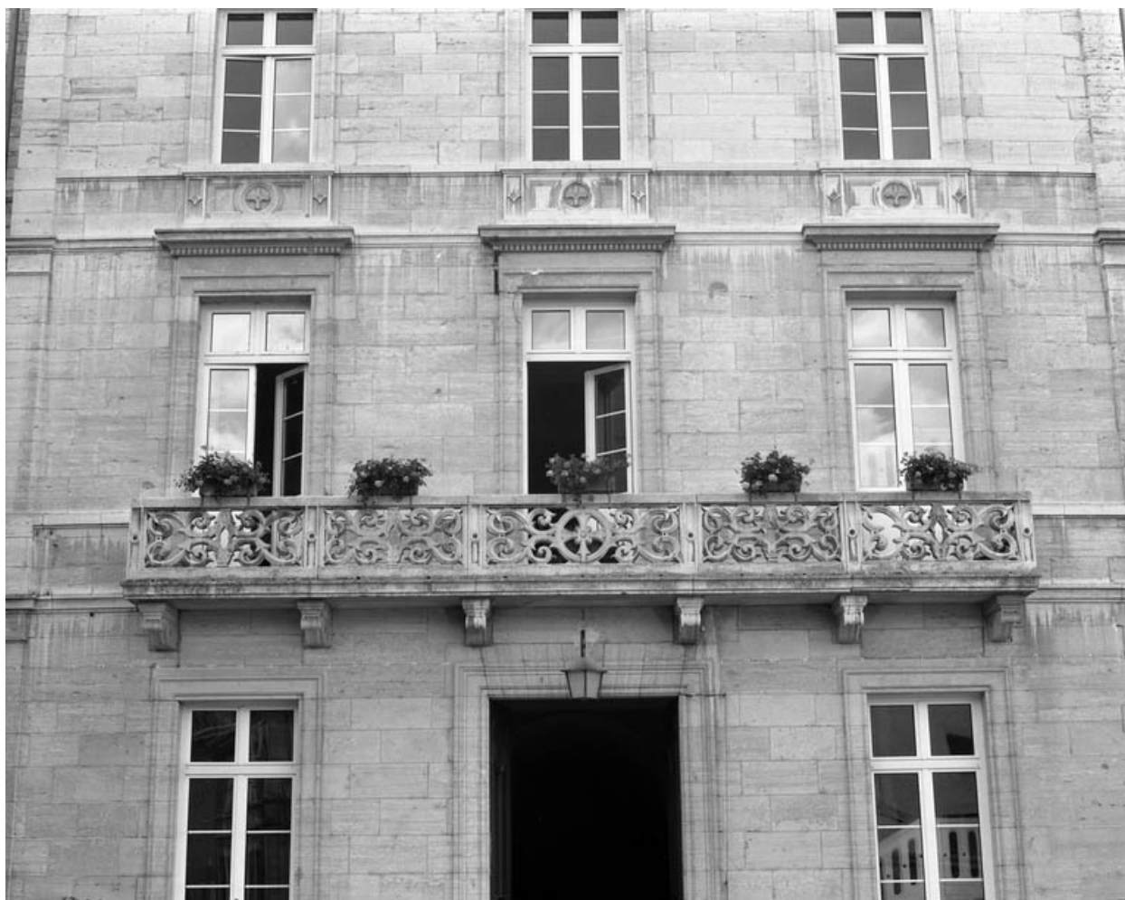
Façade principale : détail des baies du premier étage de l'avant-corps central.
