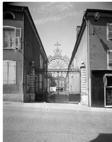
Grille d'entrée de la cour côté Grande Rue : fermée et de face.
