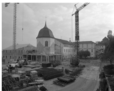
Chapelle depuis la cour donnant rue de l'Arsenal pendant les travaux de démolition de l'année 1989. Phot. Yves Sancey IVR43_19897000111X
