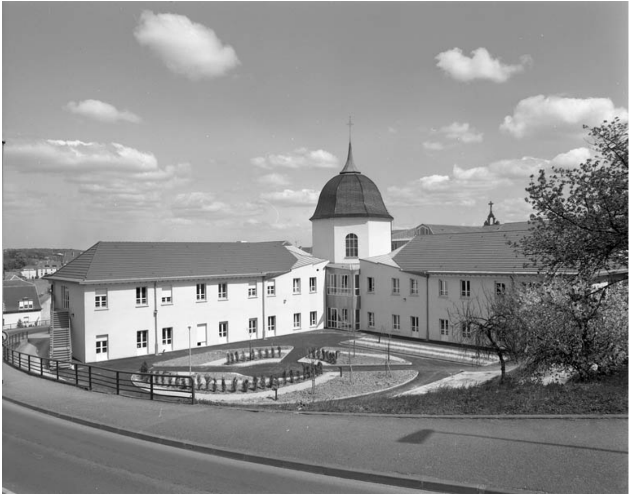
Cour à l'arrière de l'édifice : vue éloignée.
