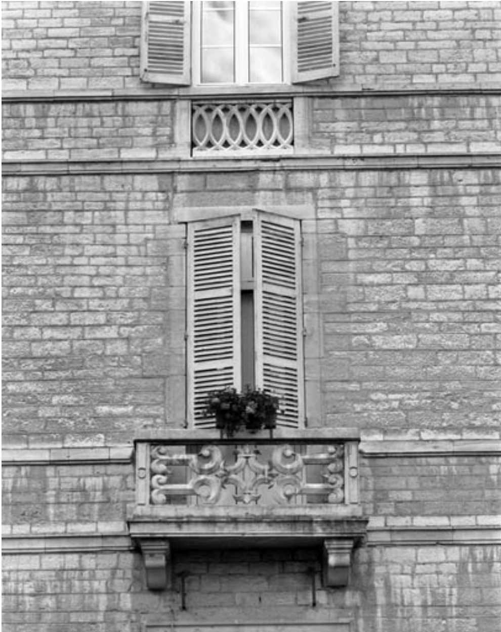
Façade principale : détail d'une baie du premier étage, partie droite.
