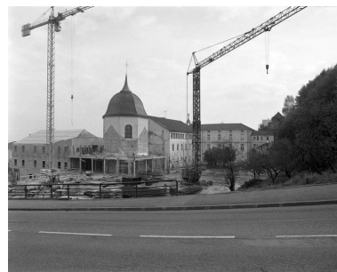
Chapelle vue depuis la rue de l'Arsenal pendant les travaux de démolition de l'année 1989. Phot. Yves Sancey IVR43_19897000110X
