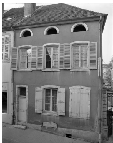
Logement de l'aumonier : façade antérieure de face.
