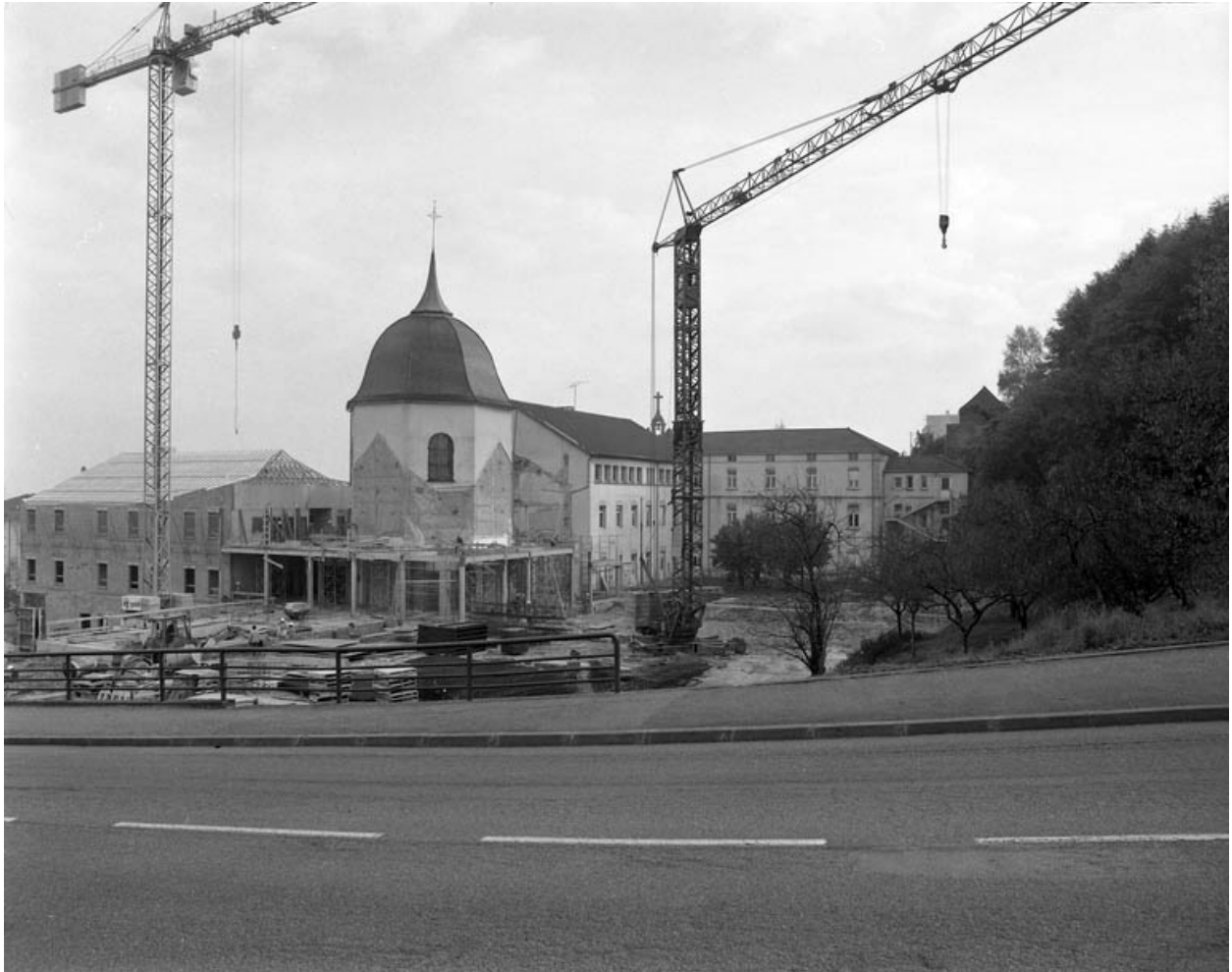
Chapelle vue depuis la rue de l'Arsenal pendant les travaux de démolition de l'année 1989.
