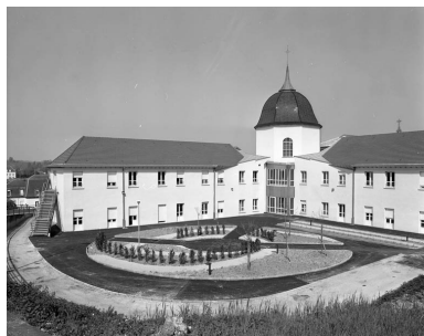
Cour à l'arrière de l'édifice : vue rapprochée. Phot. Yves Sancey IVR43_19917000239X
