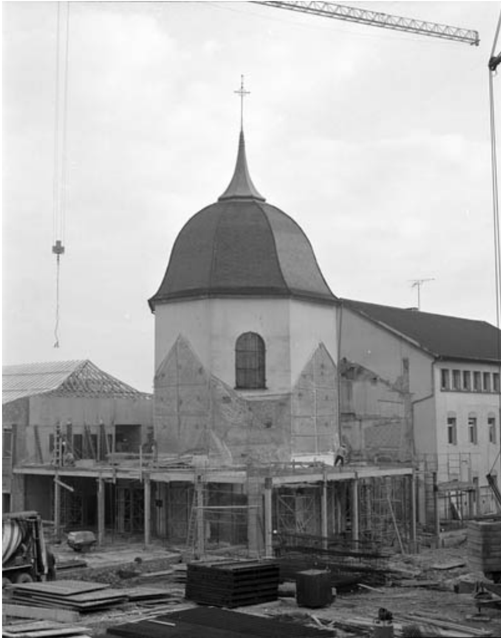
Chapelle en gros plan depuis la cour donnant rue de l'Arsenal pendant les travaux de démolition de l'année 1989.
