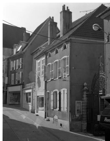
Logement de l'aumonier : façade antérieure de trois quarts gauche.
