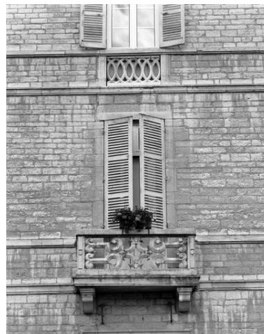
Façade principale : détail d'une baie du premier étage, partie droite. Phot. Yves Sancey IVR43_19897000109X
