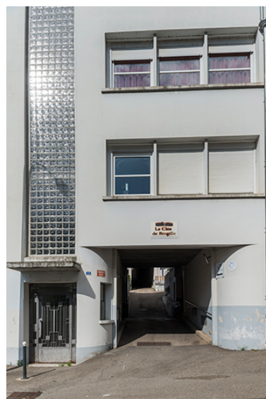
Entrée de l'usine. Phot. Jérôme Mongreville IVR43_20172501128NUC4A
