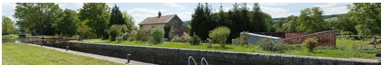
Vue d'ensemble du site d'écluse.
