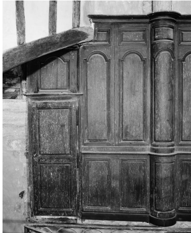
Détail de l'extrémité gauche. Phot. Michel Thierry IVR26_19792100613X
