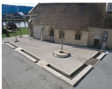
Façade latérale gauche donnant sur la place Charles le Téméraire. Phot. Yves Sancey IVR43_20032500048XA
