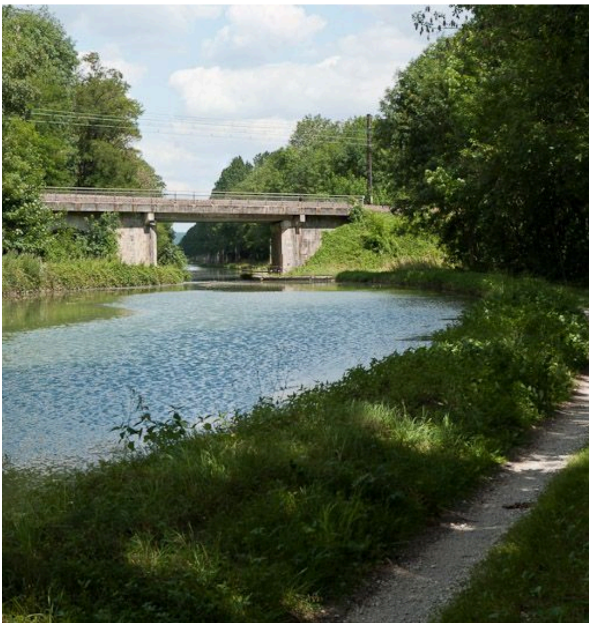
Vue du pont.
