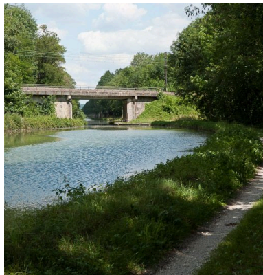
Vue du pont.
