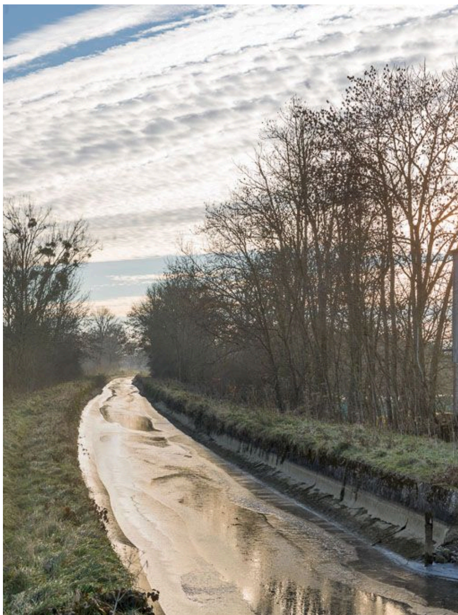
La rigole d'alimentation rive gauche.
