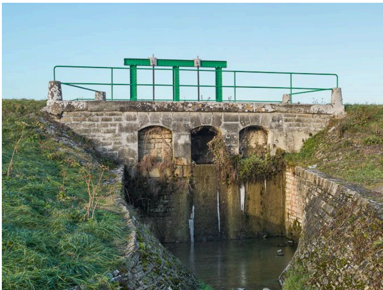
Vue du déversoir.
