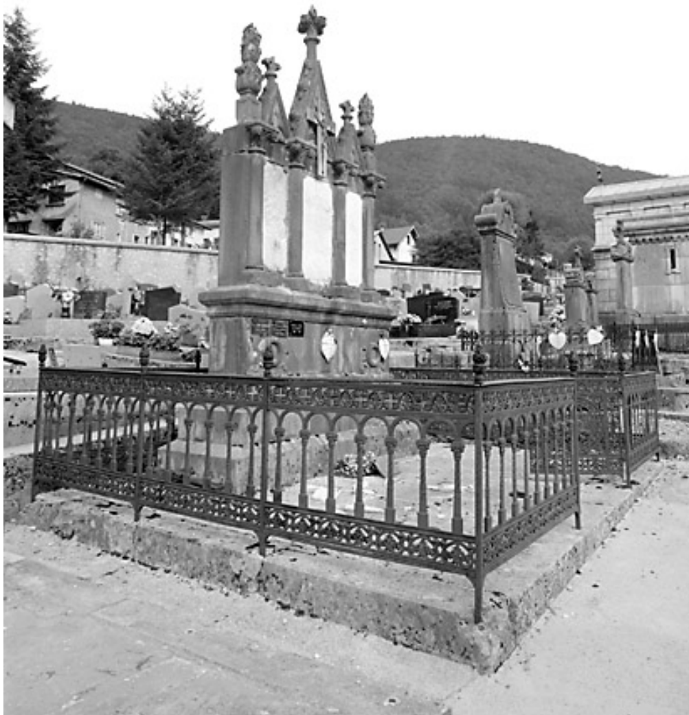
Vue d'ensemble : élévations antérieure et latérale gauche.
